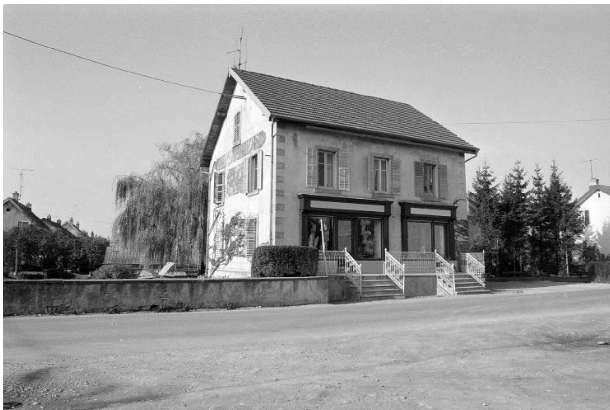
Façades antérieure et latérale gauche.
