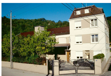
Atelier de fabrication et bureau. Phot. Laurent Poupard IVR43_19913901295ZA
