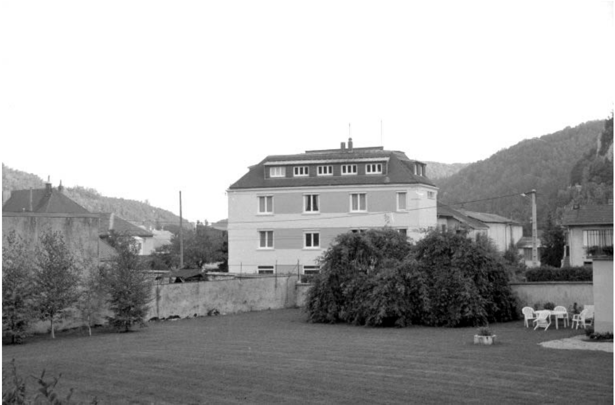
Façade latérale droite du bureau.
