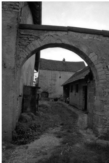
Chemin d'accès. Phot. Bernard Lardière IVR43_19797000032Z
