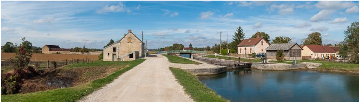
Vue d'ensemble du site d'écluse. A gauche, la maison éclusière, à droite, la maison de garde.
