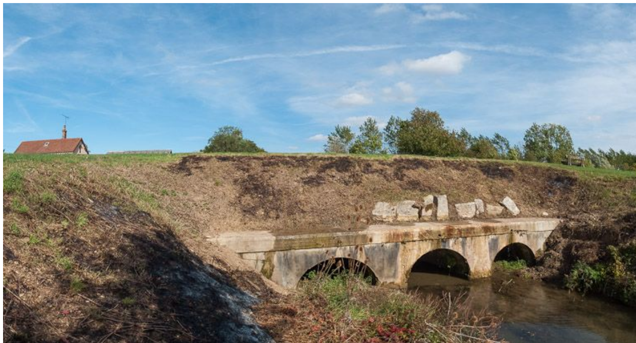
Aqueduc en amont du sas.
