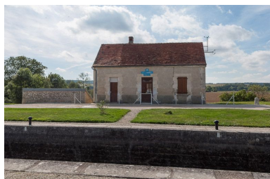
Maison éclusière vue de face.
