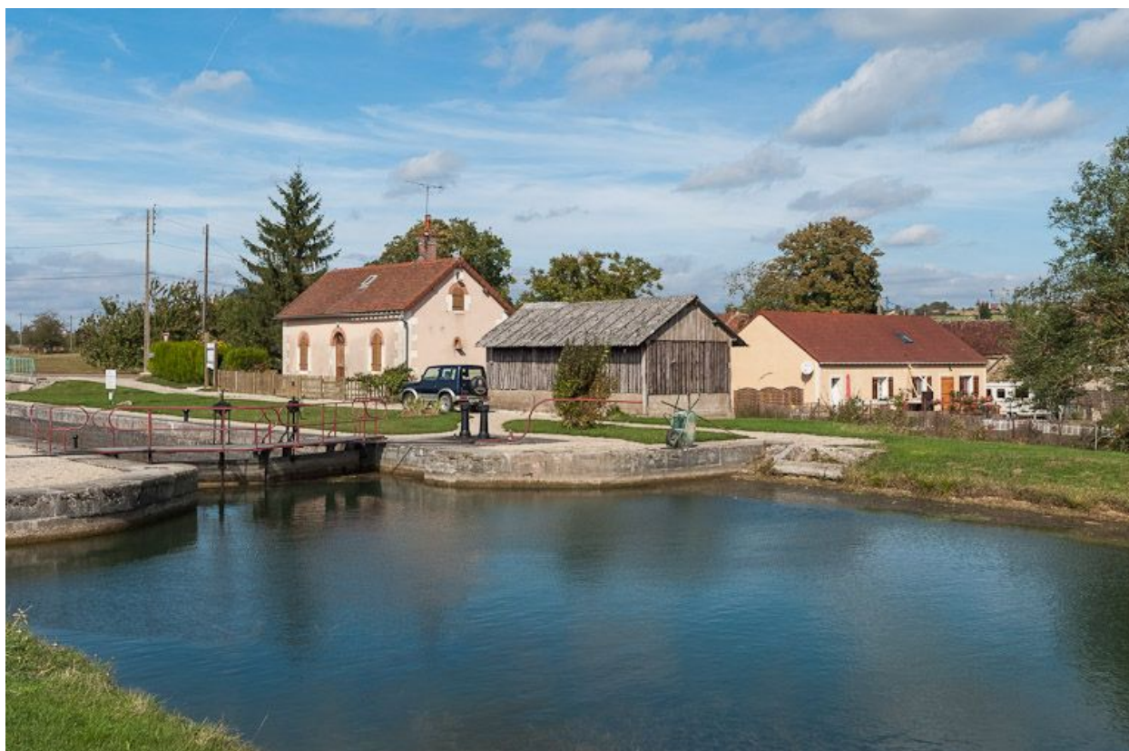
Vue d'ensemble du site avec maison de garde et hangar.
