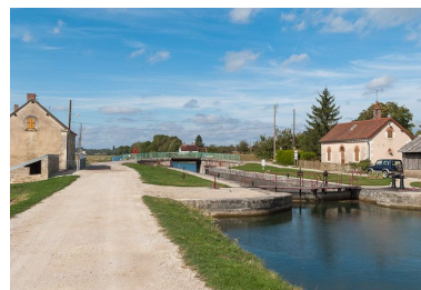
Vue d'ensemble du site d'écluse, avec de gauche à droite, la maison éclusière et la maison de garde.
