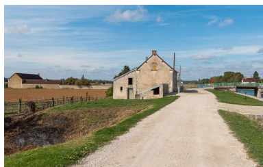
La maison éclusière avec ses appentis.
