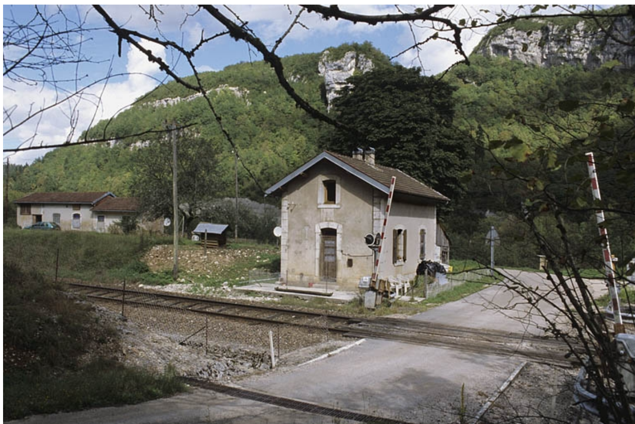
Façades antérieure et latérale droite.
