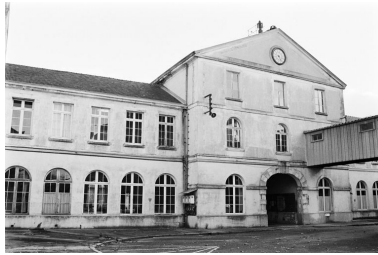
Façade postérieure des ateliers et bureaux centraux.
