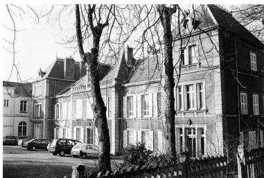
Façade antérieure de la "maison d'administration".
