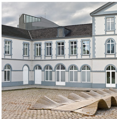
Vue extérieure : détail de la façade.
