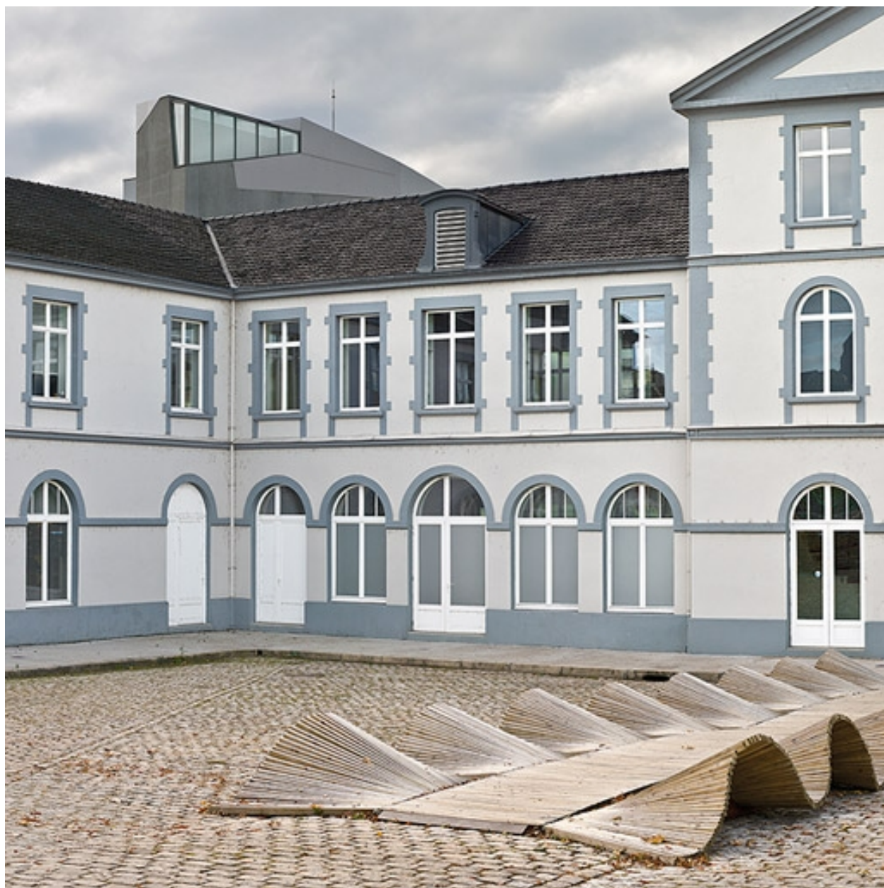
Vue extérieure : détail de la façade.
