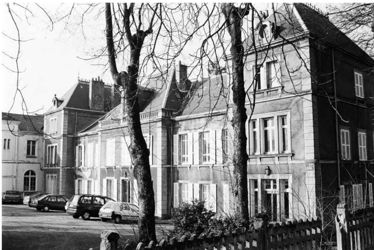
Façade antérieure de la " maison d'administration ".
