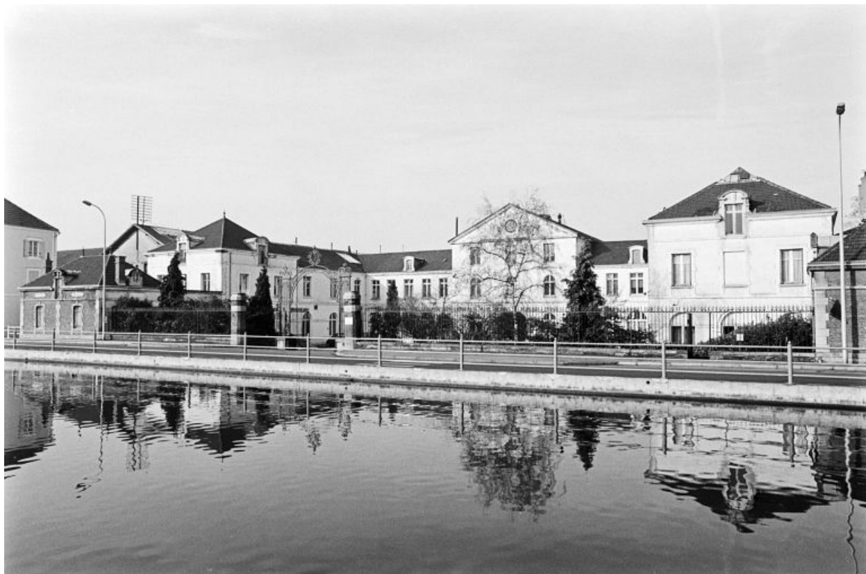
Façade antérieure des ateliers et bureaux centraux.
