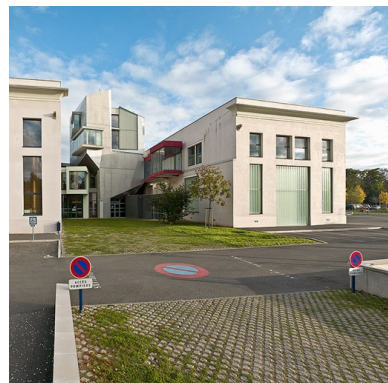
Vue extérieure, façade postérieure.
