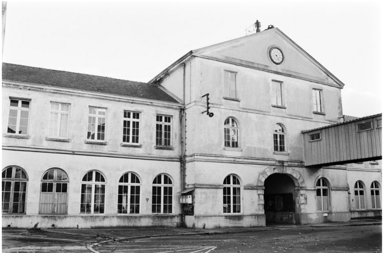
Façade postérieure des ateliers et bureaux centraux.
