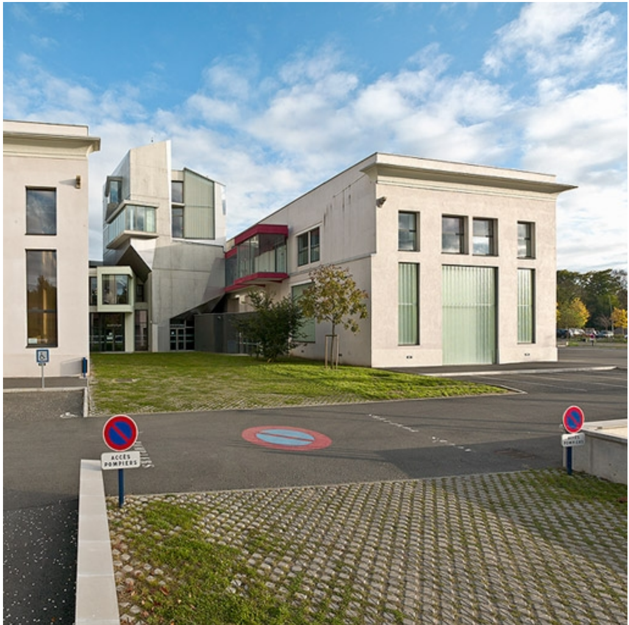
Vue extérieure, façade postérieure.
