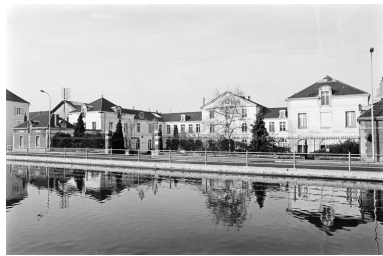
Façade antérieure des ateliers et bureaux centraux.
