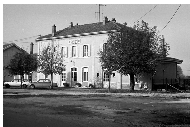
Vue de trois quarts. Phot. Bernard Lardière IVR43_19832500132Z
