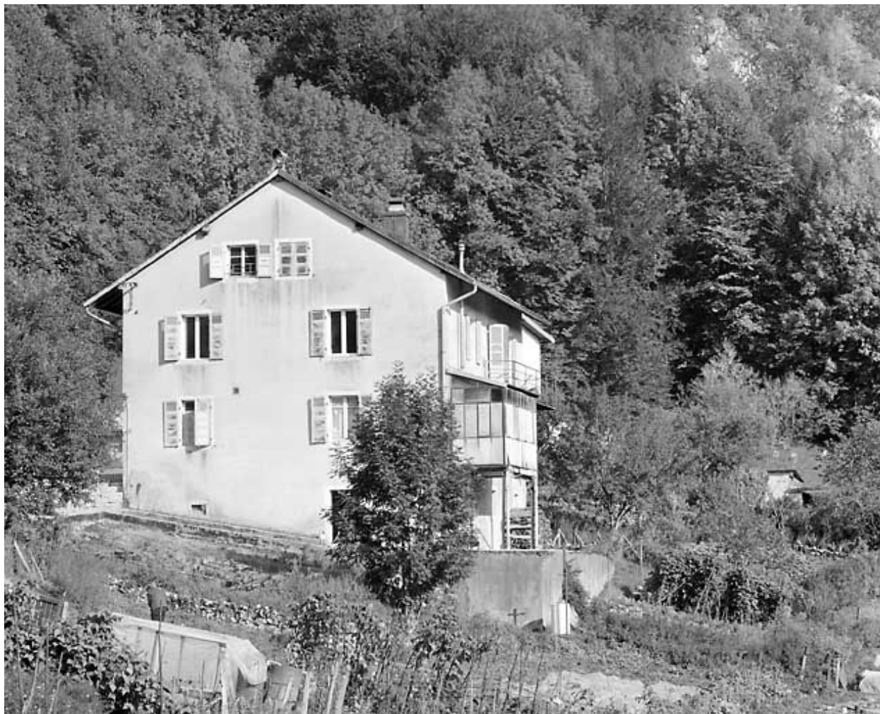
Façades latérale droite et postérieure.
