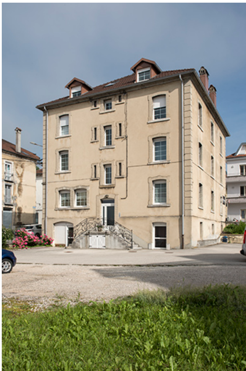
Façades sud (entrée, sur cour) et est.
