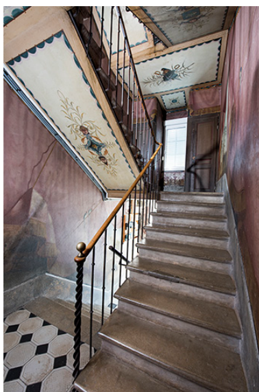
Cage d'escalier décorée. Phot. Sonia Dourlot IVR43_20182500743NUC4A
