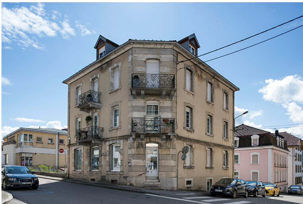
Vue d'ensemble, sur le pan coupé.
