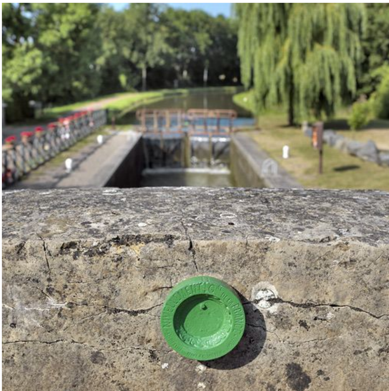
Parapet du pont sur écluse, avec au premier plan le repère de nivellement Bourdaloué.
