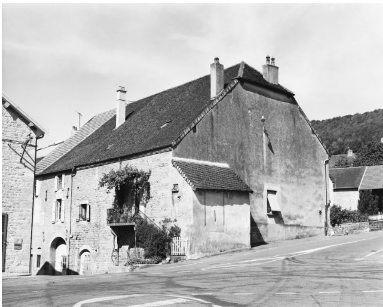
Façades postérieure et latérale gauche.
