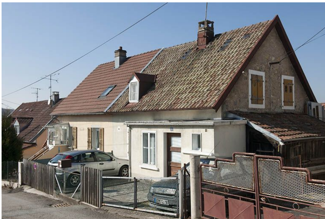
Maison jumelée rue d'Alsace.
