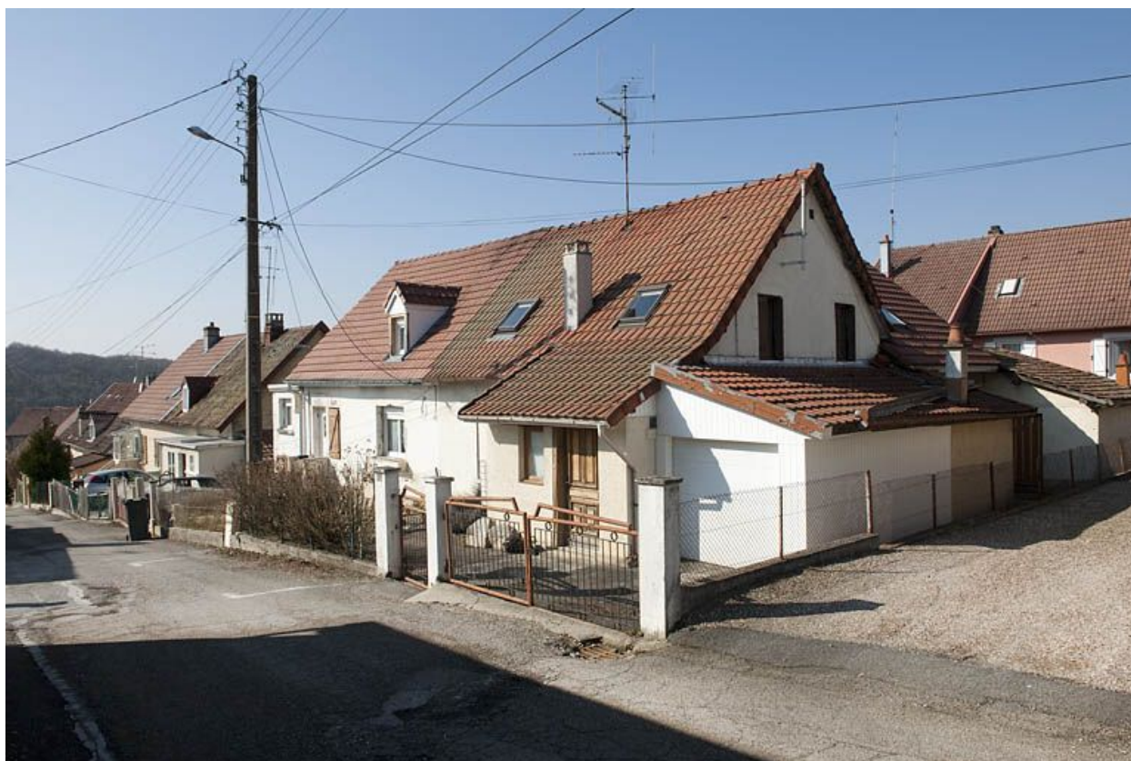
Maisons jumelées rue d'Alsace.
