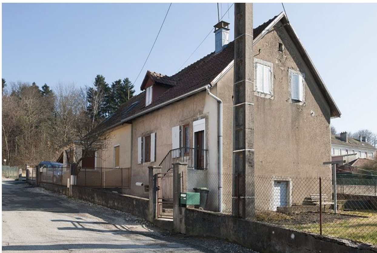
Maison jumelée rue d'Alsace.
