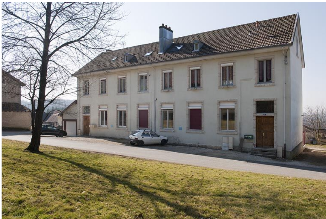
Ecole. Façade est.
