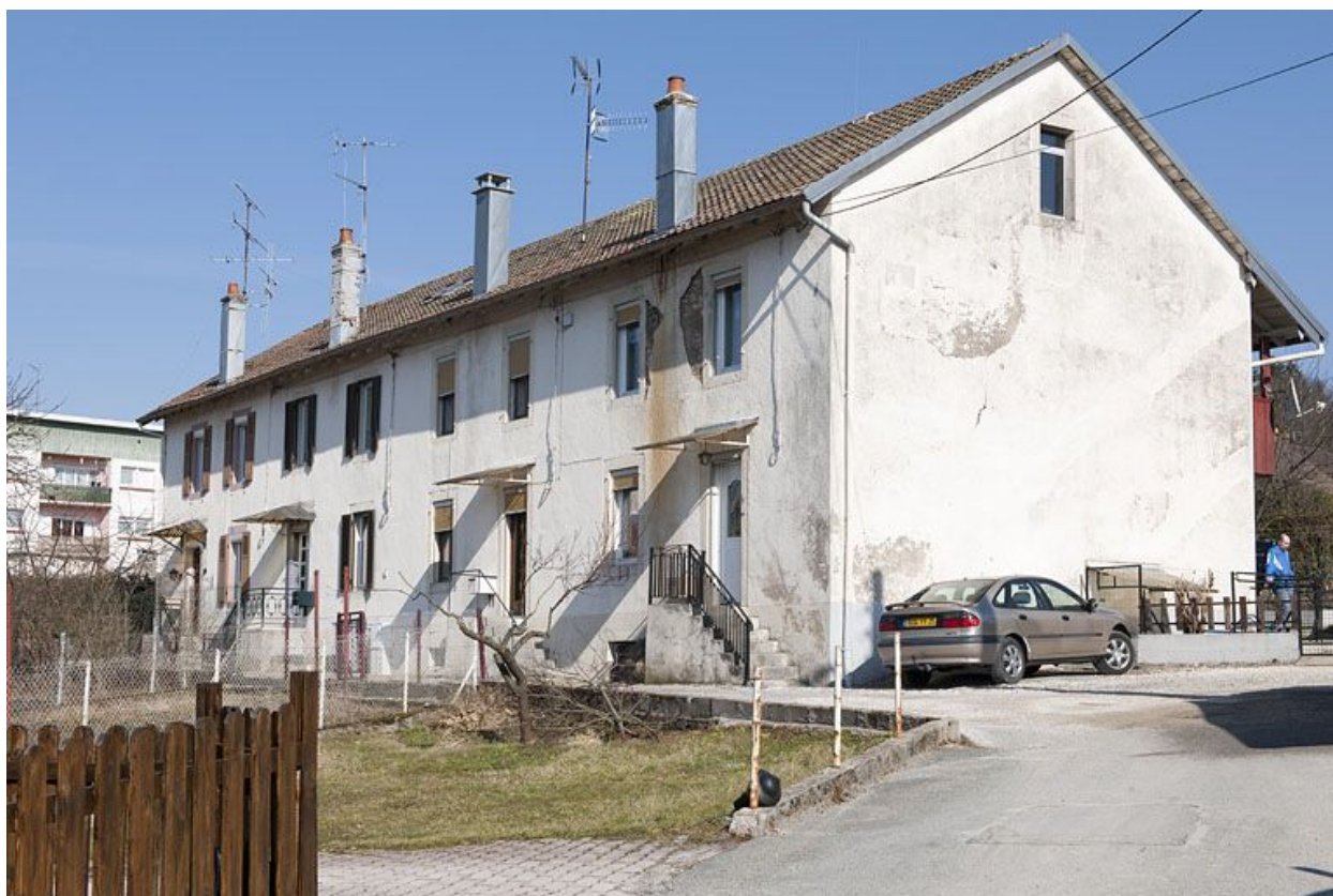
Habitation à 8 logements (?) rue du Nègre.
