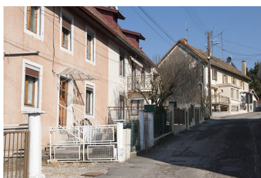
Maisons à 2 logements (?) rue d'Alsace. Phot. Jérôme Mongreville IVR43_20122500147NUC4A
