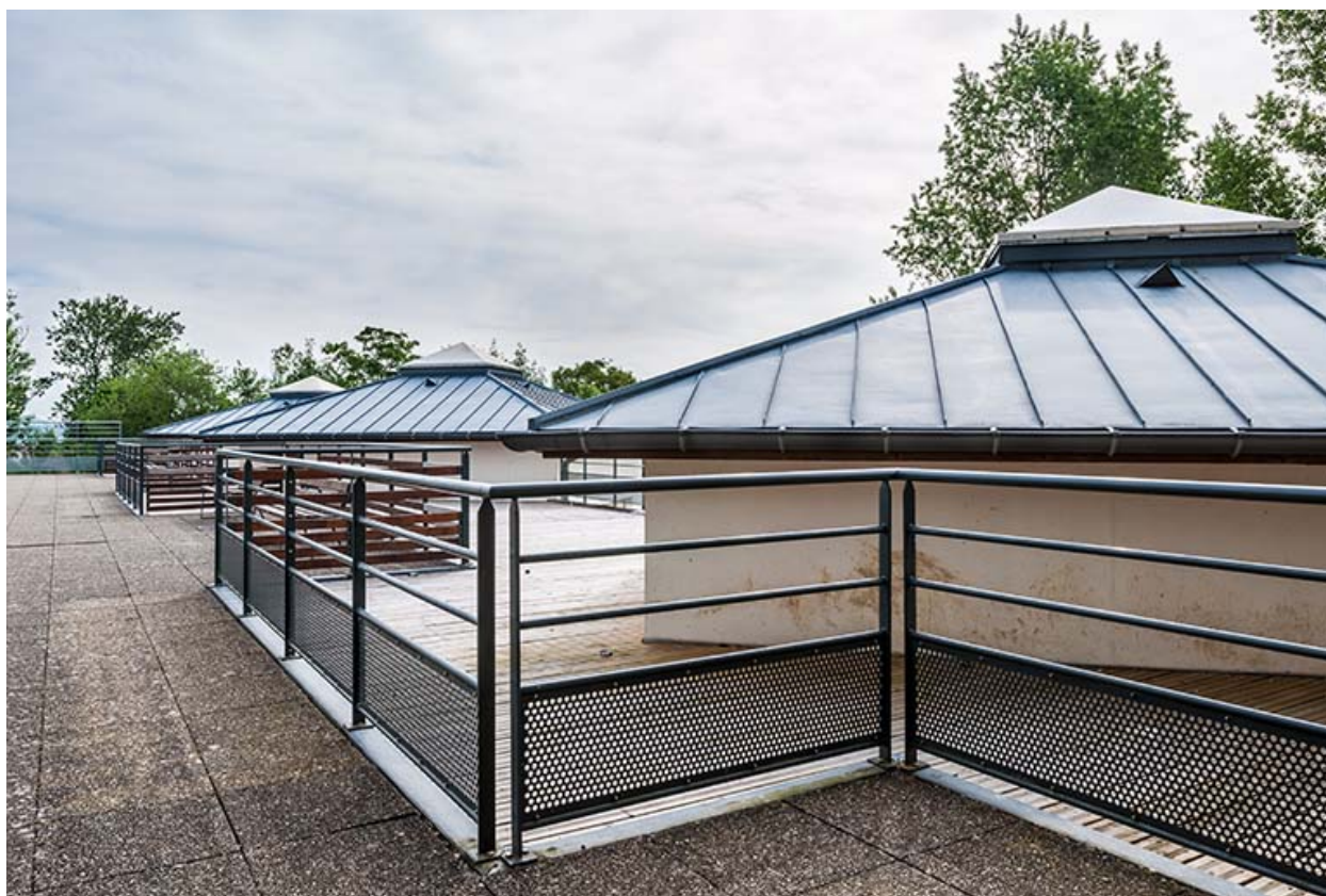
Terrasse et toiture des ateliers.
