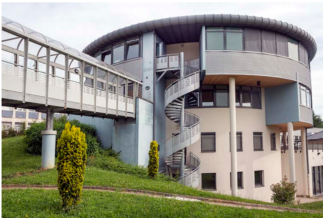
Passerelle, tour et son escalier au sud-ouest.
