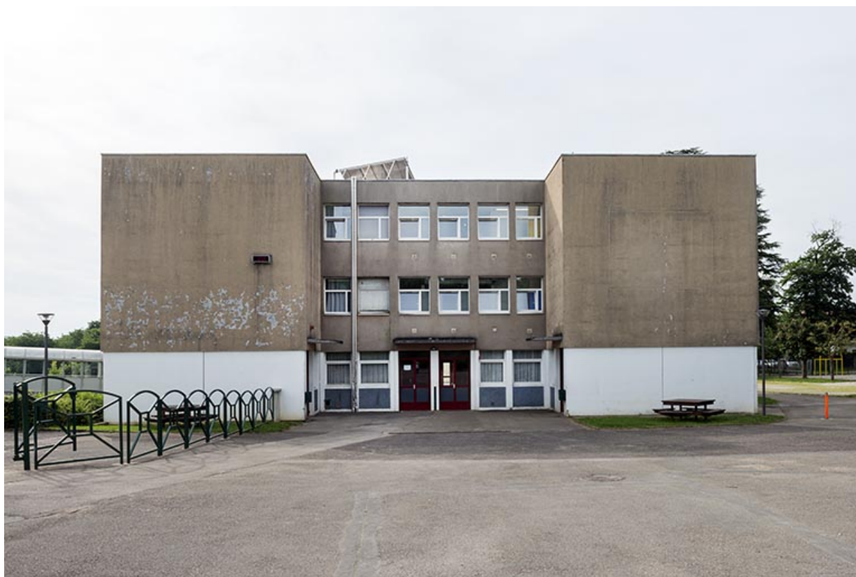
Entrée du bâtiment d'internat et restauration.
