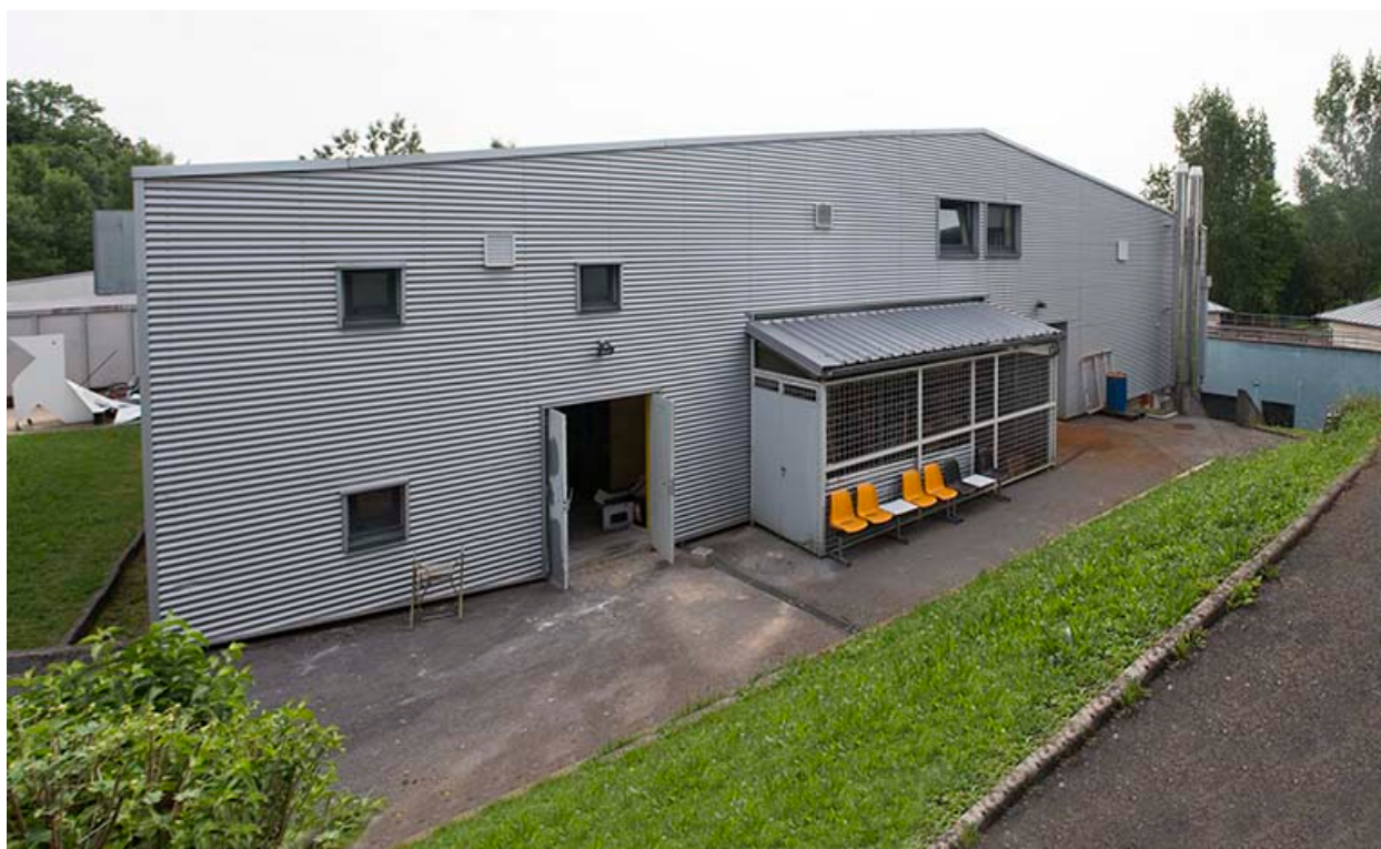
Façade sud-ouest des ateliers.
