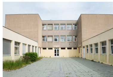
Cour postérieure du bâtiment d'internat et restauration.
