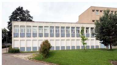
Façade nord-est du bâtiment d'internat et restauration.
