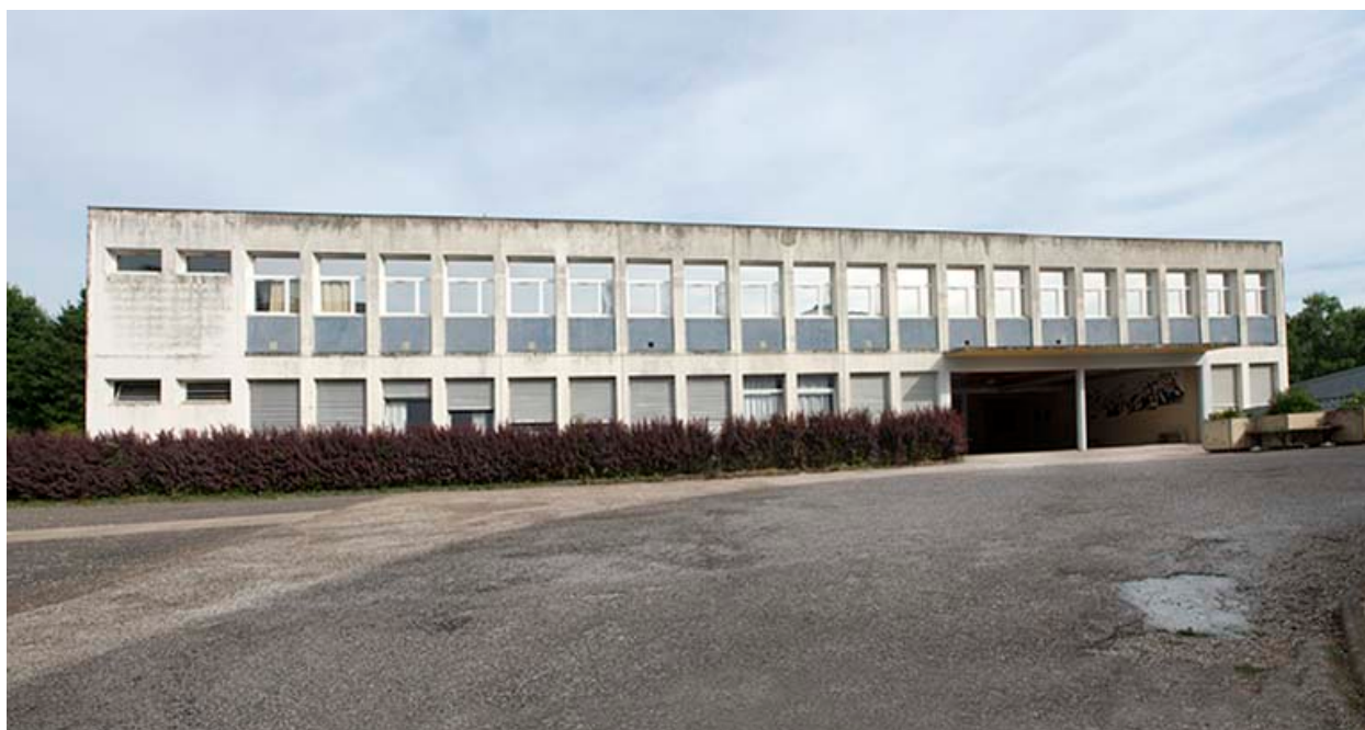
Façade sud-est de l'externat et préau.
