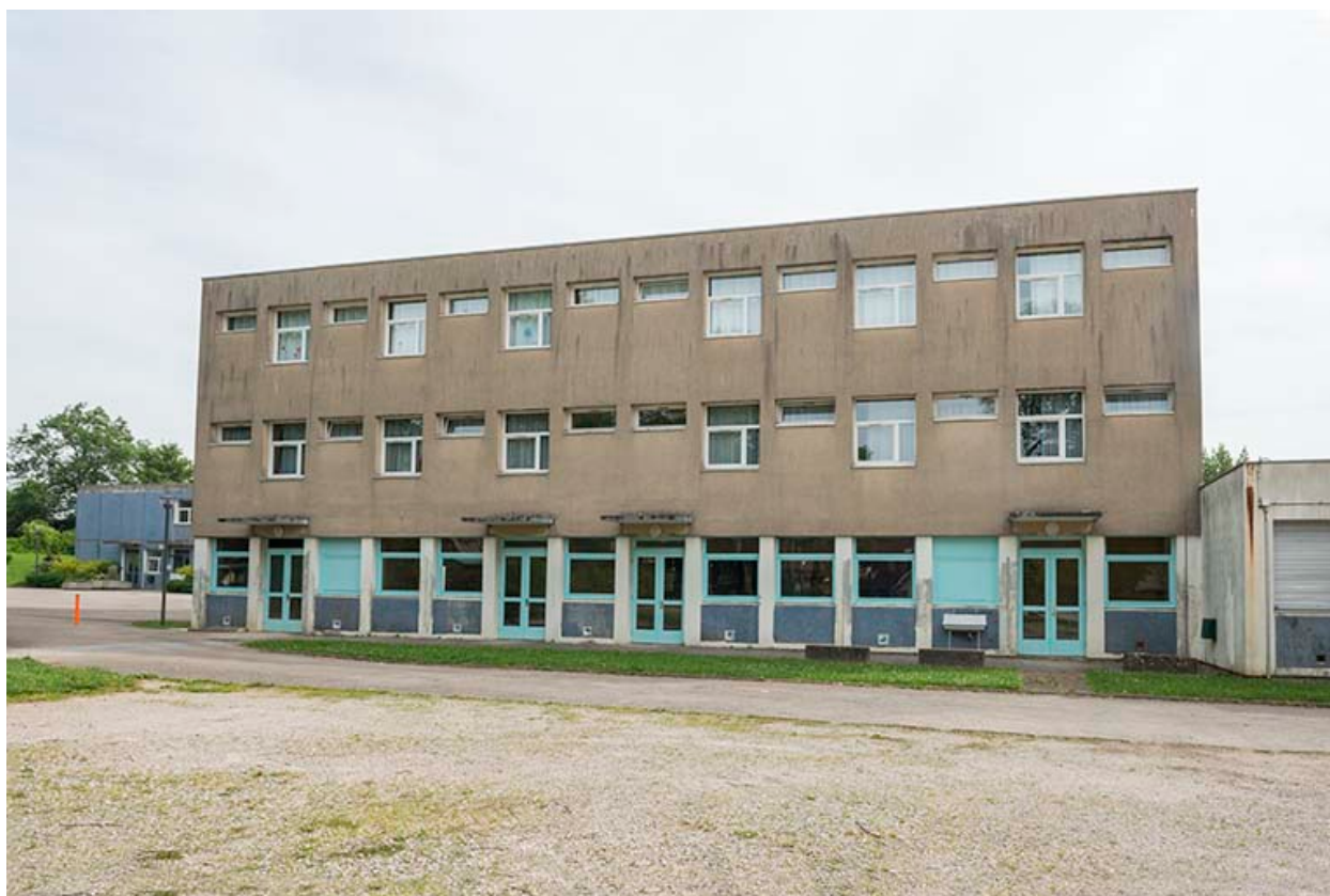
Façade sud-ouest de l'internat restauration.
