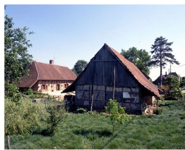
Vue d'ensemble avec le bâtiment agricole en 1990. Phot. Yves Sancey IVR43_19903901125XA
