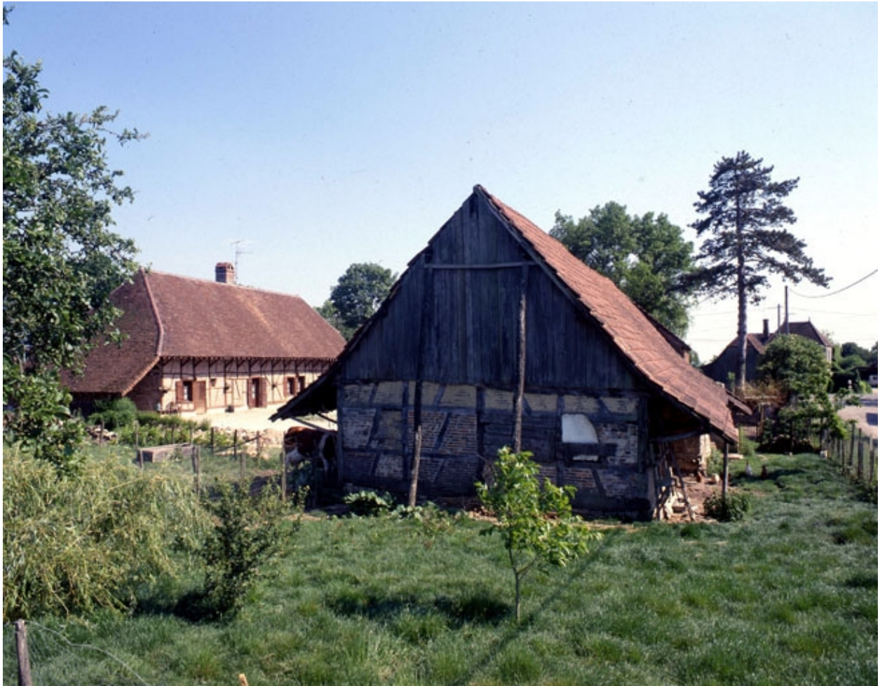
Vue d'ensemble avec le bâtiment agricole en 1990.
