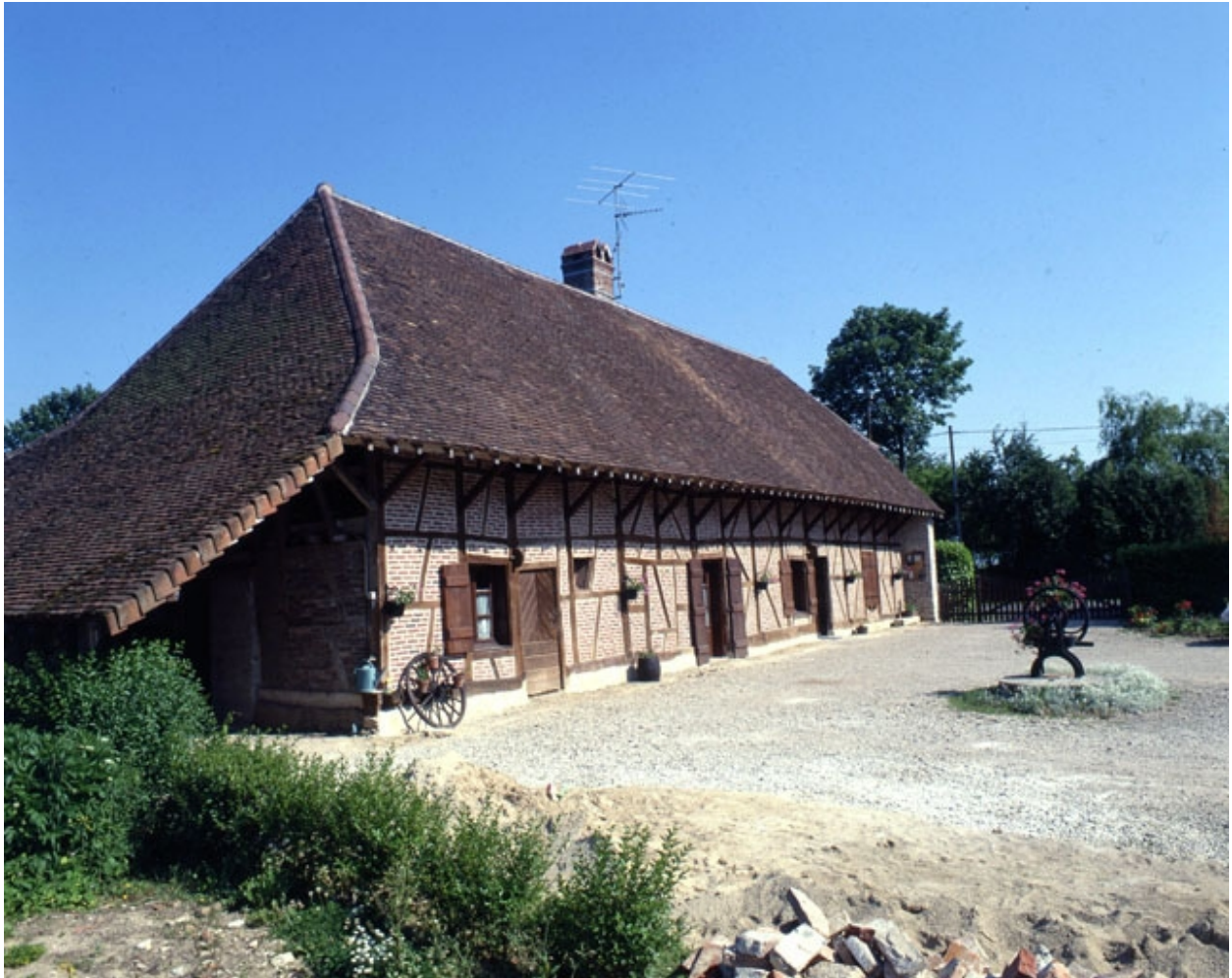
Bâtiment d'habitation : façade antérieure et cour en 1990.
