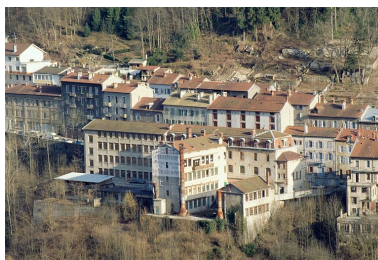
Vue d'ensemble depuis l'ouest. Phot. Laurent Poupard IVR43_19923901326ZA
