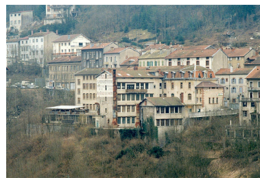
Vue d'ensemble depuis l'ouest. Phot. Laurent Poupard IVR43_19923901392ZA
