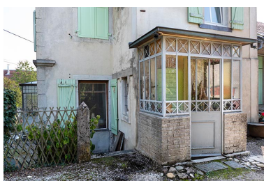
Logement Hugoniot : véranda nord, de trois quarts. Phot. Sonia Dourlot IVR43_20192501210NUC4A
