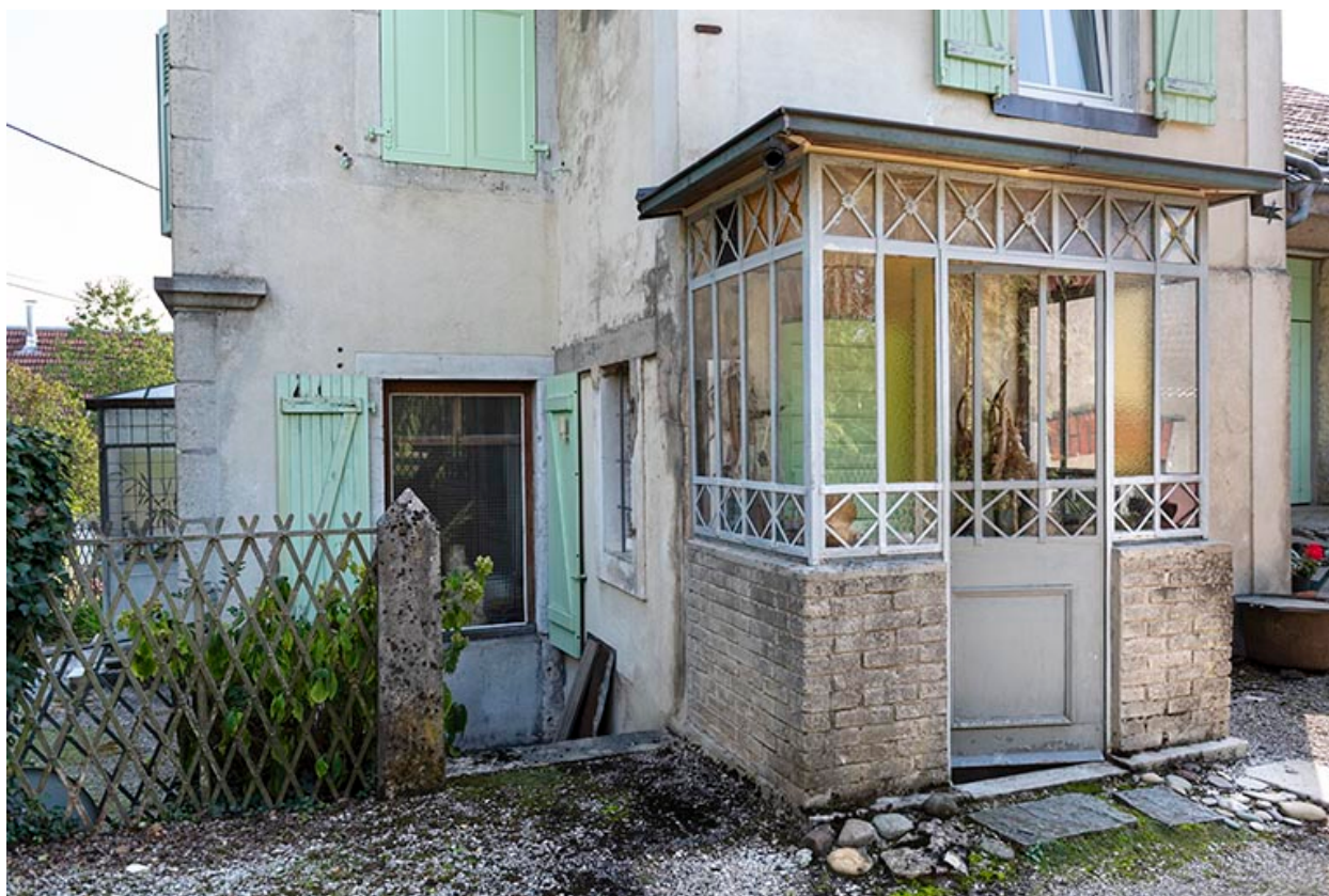
Logement Hugoniot : véranda nord, de trois quarts.
