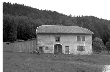
Ferme située au lieu-dit les Chalettes. Phot. Jérôme Mongreville IVR43_20003900478X
