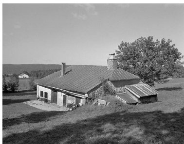
Ferme située 56 route des Préhez. Phot. Jérôme Mongreville IVR43_20003900447X
