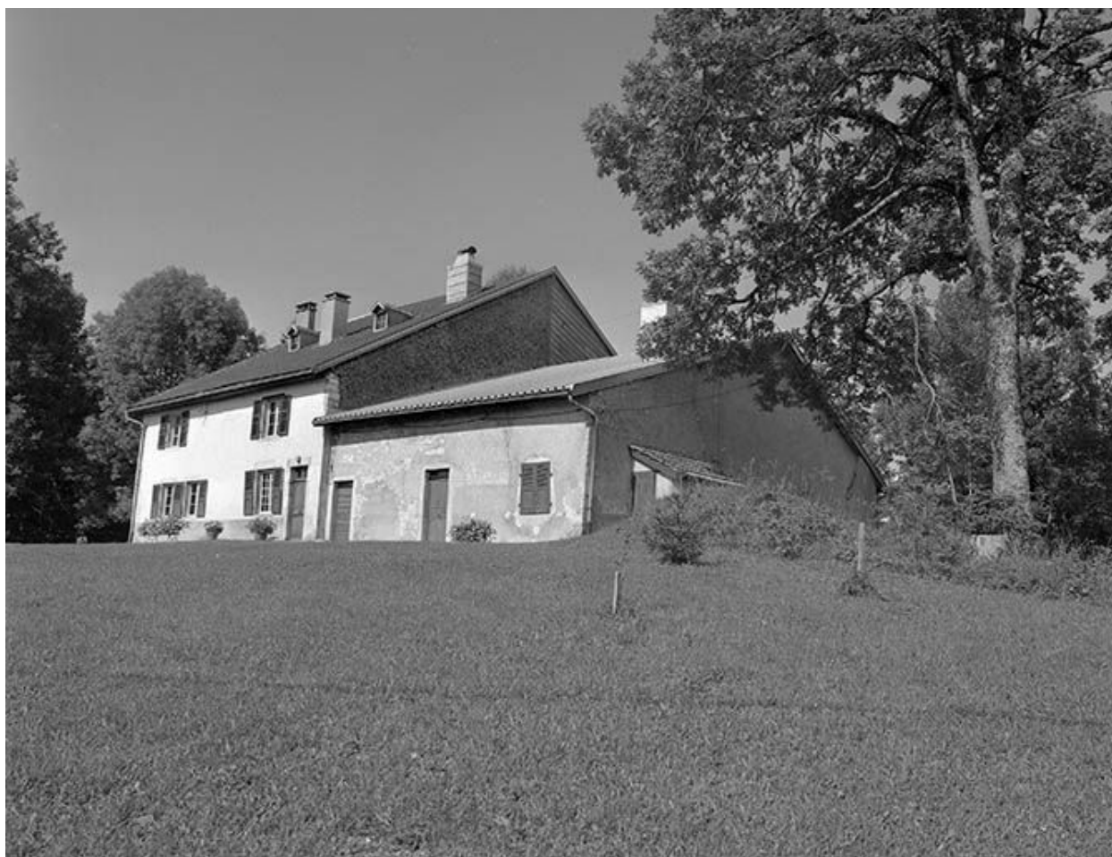
Ferme située au lieudit Les Petits Valets.
