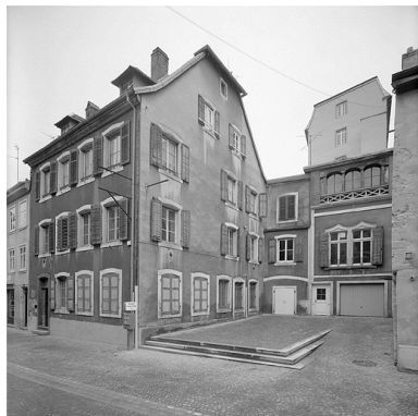
Vue d'ensemble. Phot. Jérôme Mongreville IVR43_19882500042V
