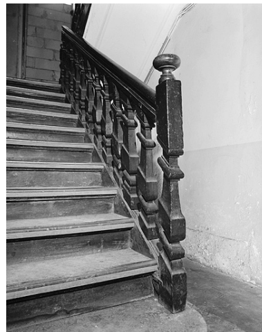
Escalier. Phot. Jérôme Mongreville IVR43_19872500496X
