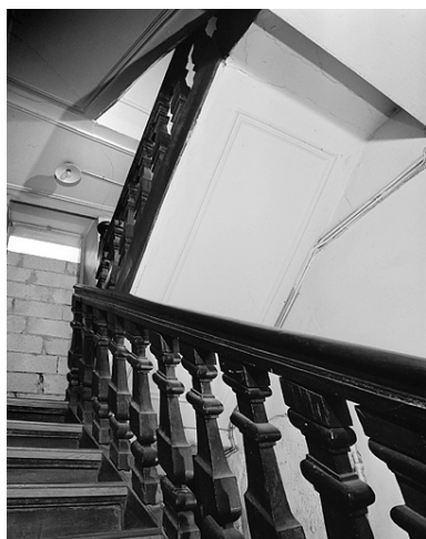
Escalier. Phot. Jérôme Mongreville IVR43_19872500497X
