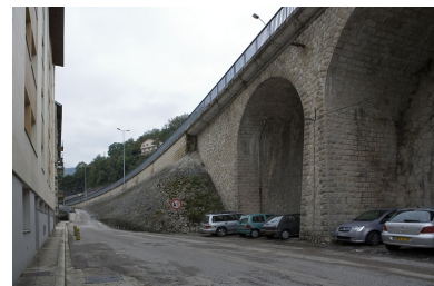
Jonction entre le perré et la première arcade. Phot. Yves Sancey IVR43_20073900323NUCA
