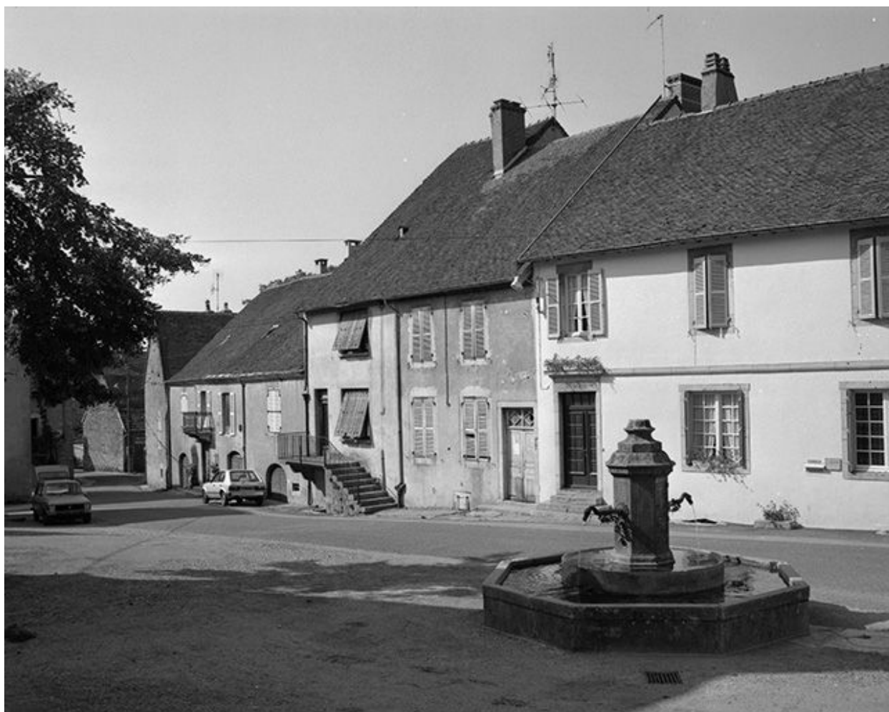
Vue de situation.
