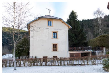
Façade latérale droite. Phot. Sonia Dourlot IVR43_20162501649NUC4A
