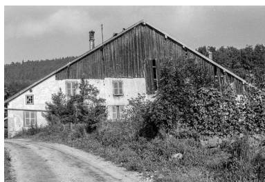
Ferme : vue d'ensemble depuis le chemin. Phot. Gilbert Poinot IVR43_19752501267Z
