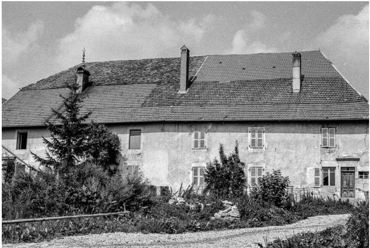
Ferme cadastrée 1972 ZM 63a-64a : façade antérieure.
