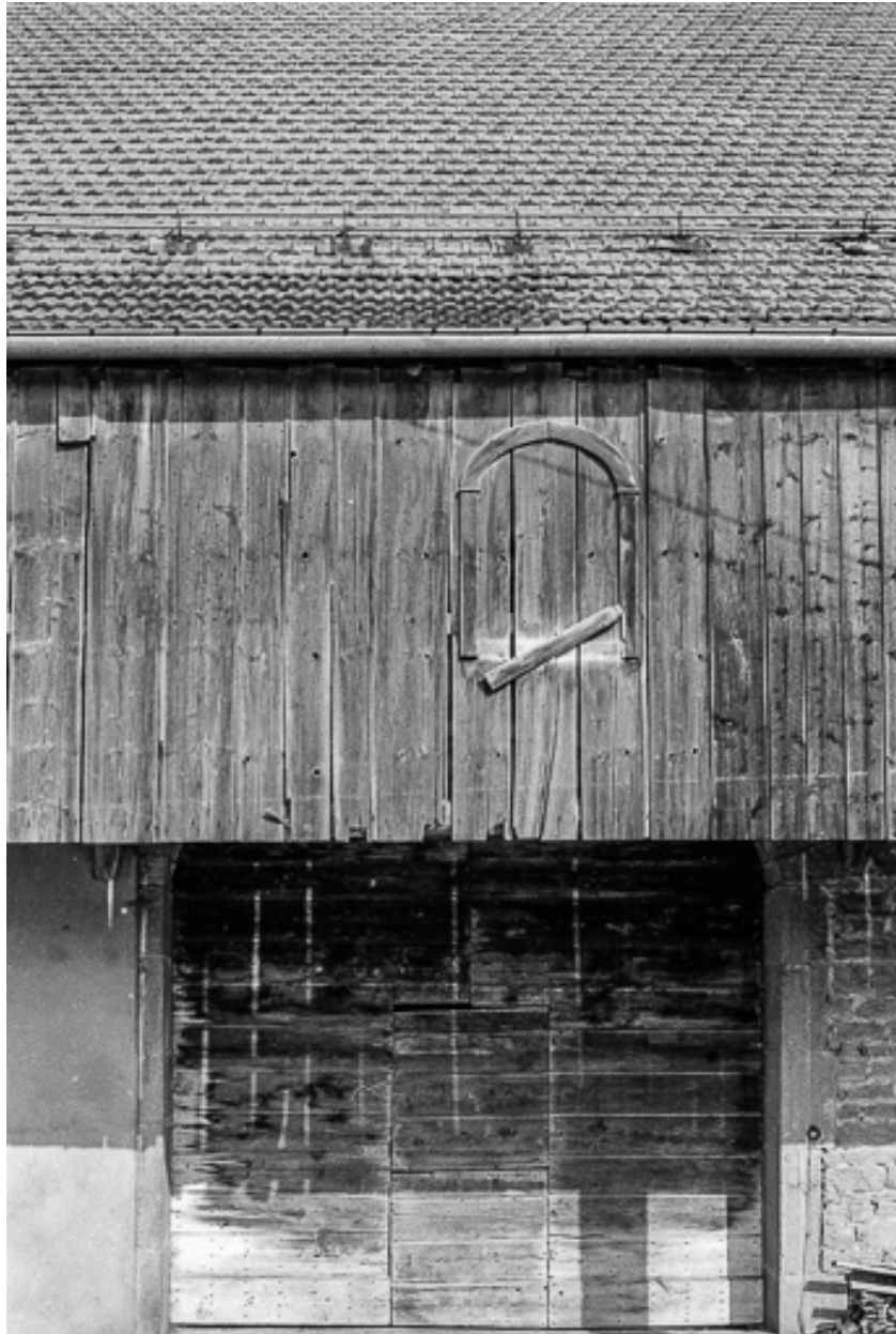
Ferme située 1 rue de Longeville : fermeture de l'auvent par une galerie supérieure.
