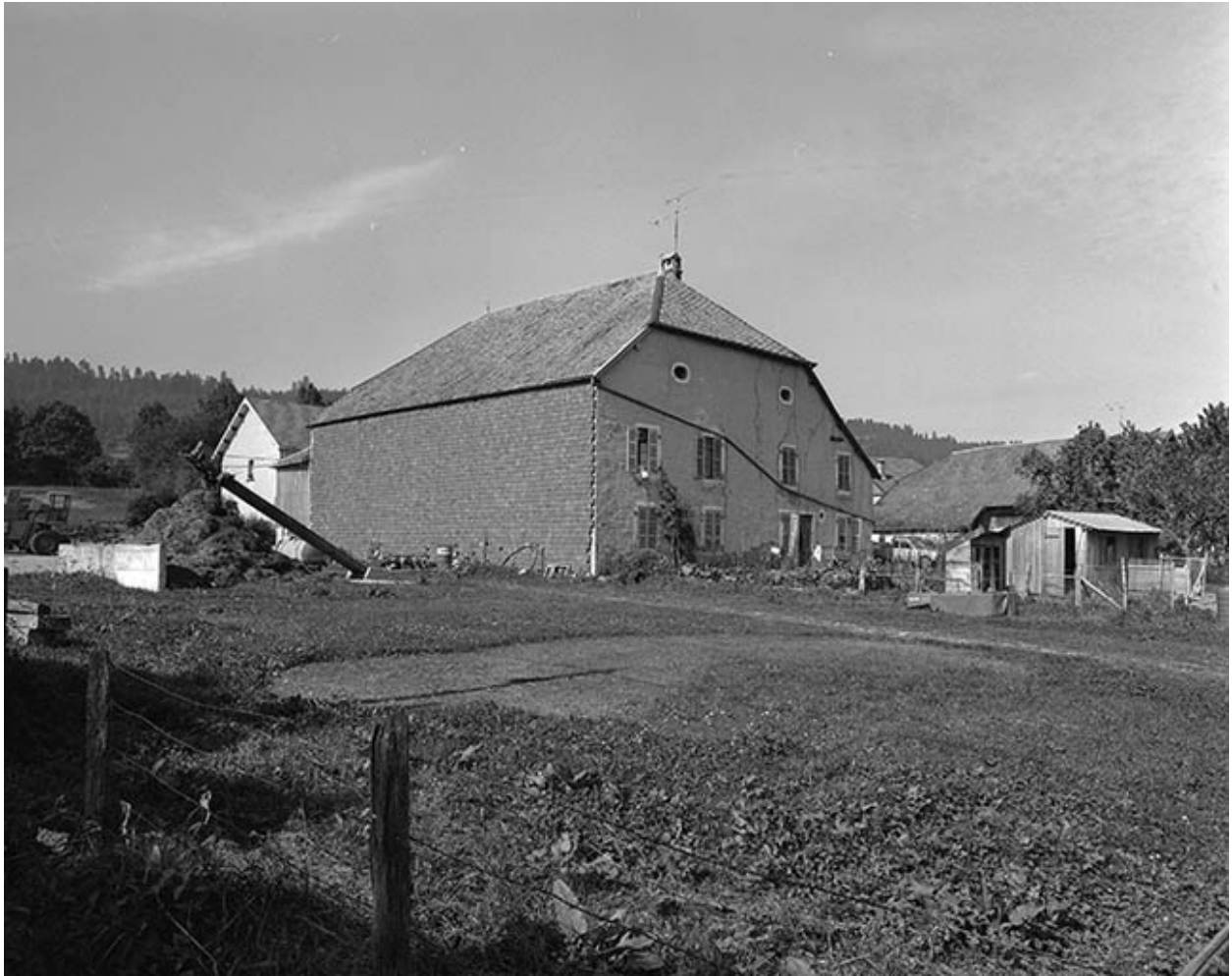
Ferme cadastrée 1972 ZM 94 a, datée de 1878 : façade antérieure et latérale droite essentée de petites tuiles.
