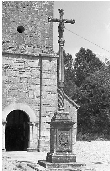
Vue générale. Phot. Guy Forestier IVR43_19743900360Z
