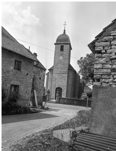
Extérieur : façade antérieure vue éloignée. Phot. Yves Sancey IVR43_19837000111X
