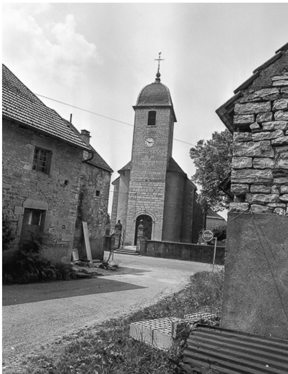
Extérieur : façade antérieure vue éloignée.
