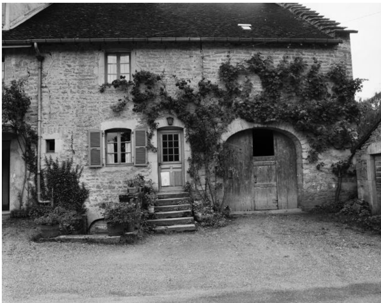
Ferme située rue du Prebytère : façade antérieure.
