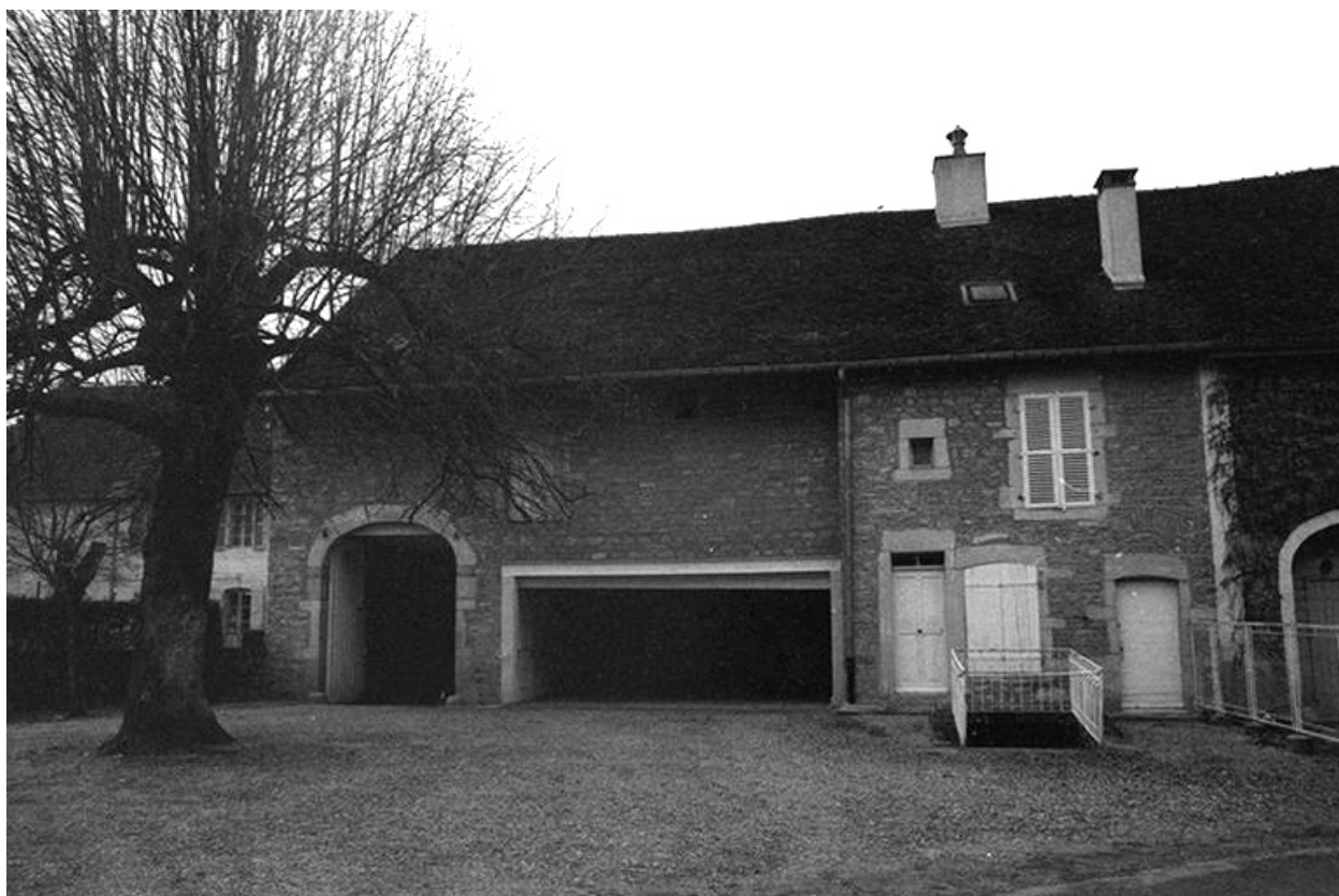
Maison de vigneron : façade antérieure.
