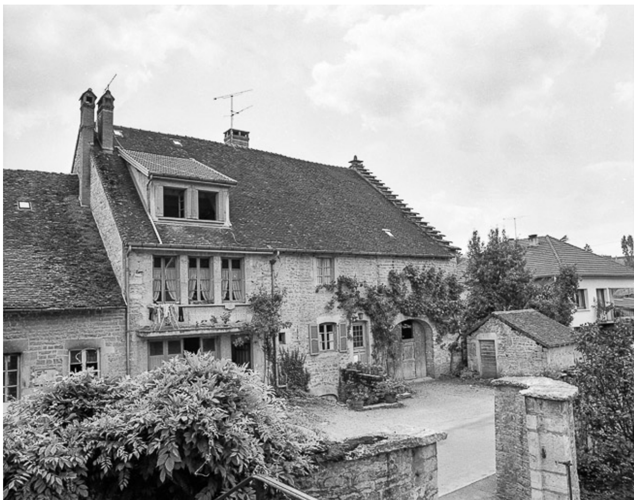
Ferme située rue du Presbytère : vue d'ensemble.
