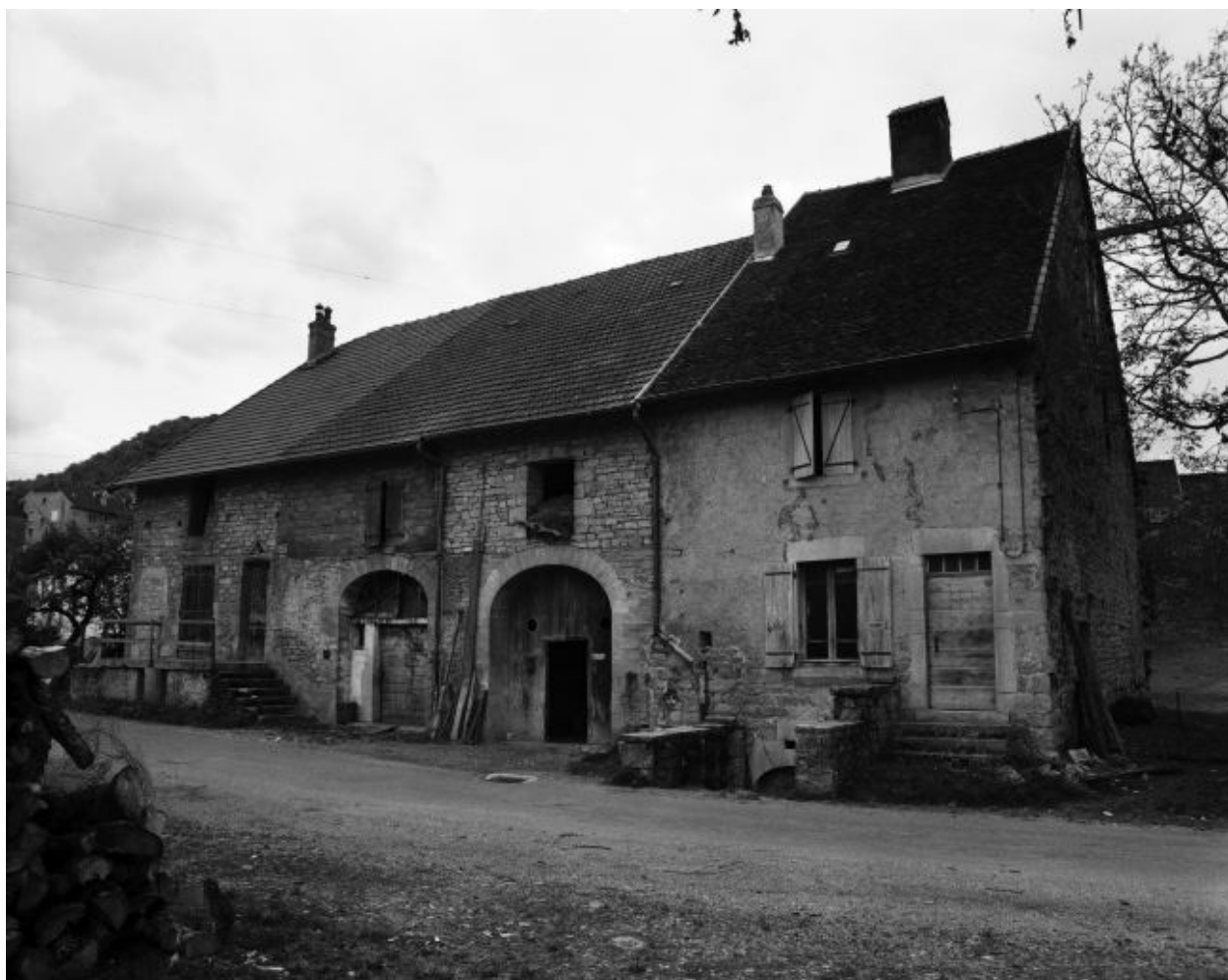
Ferme située rue des Guichard : vue d'ensemble.
