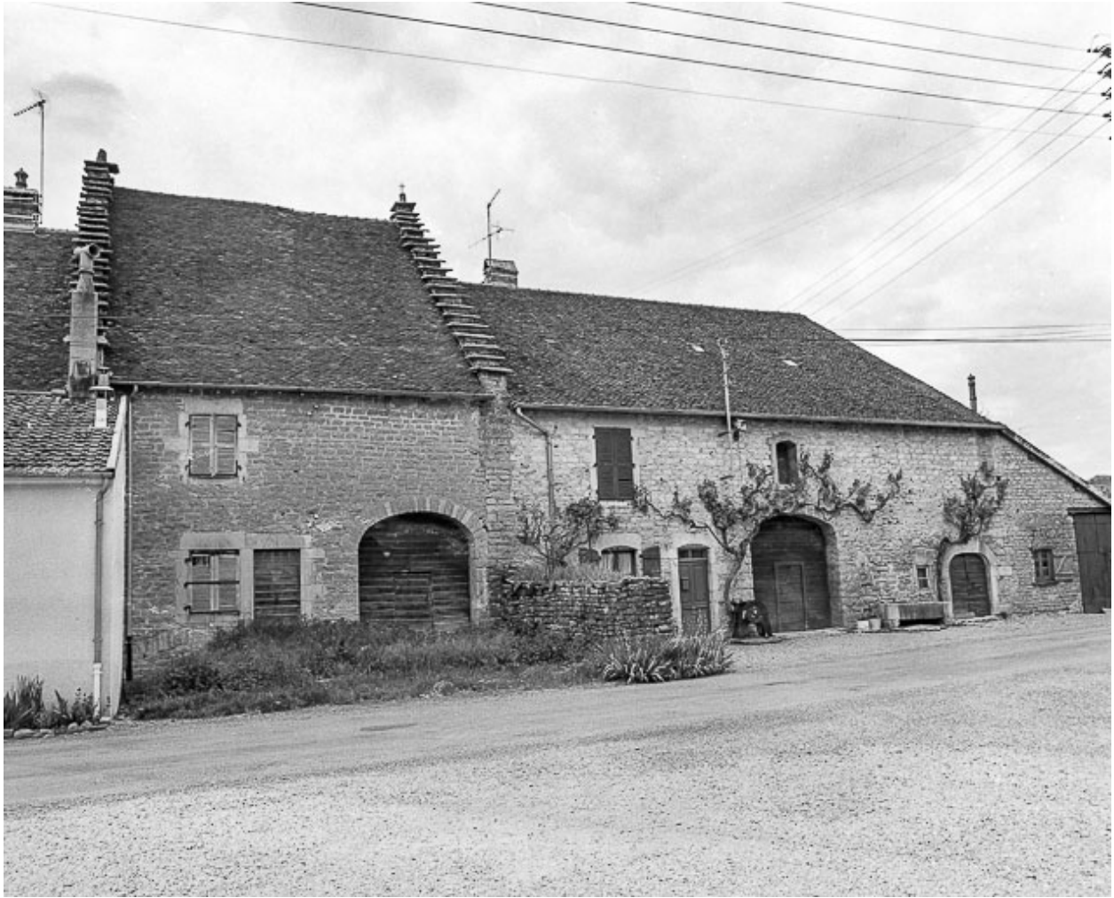
Fermes situées rue Roche : façades antérieures.
