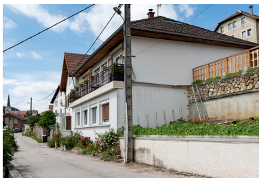
Façades antérieure et latérale droite.
