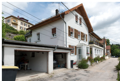
Façades antérieure et latérale gauche.
