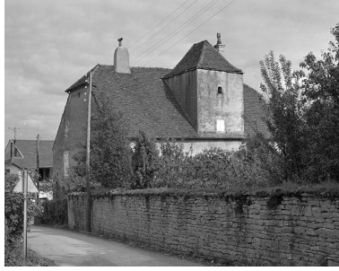
Façade postérieure. Phot. Yves Sancey IVR43_19813900251X
