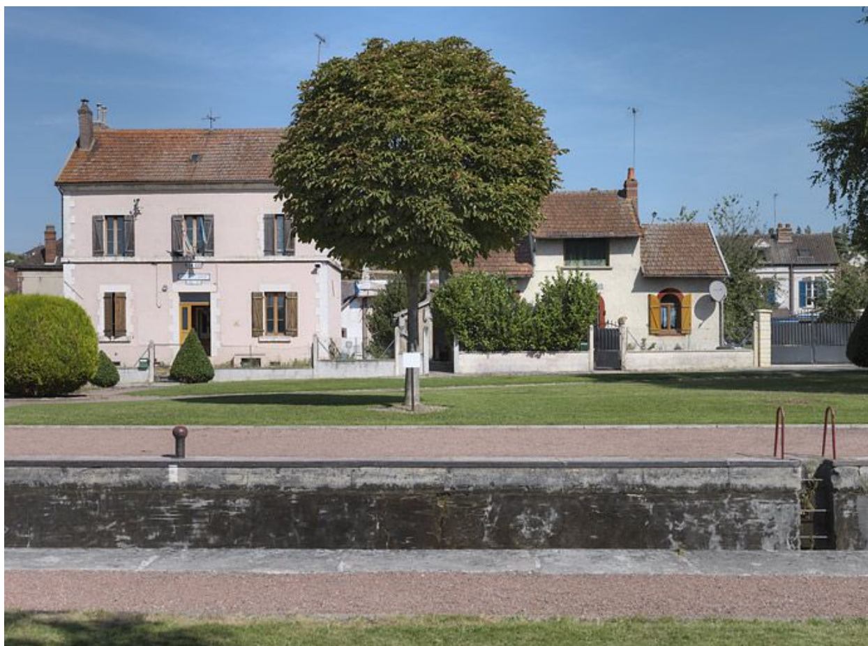
Les deux maisons de face.
