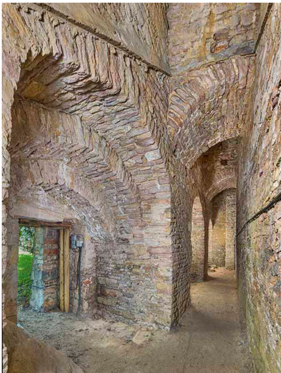
Poterne d'accès à la galerie.
