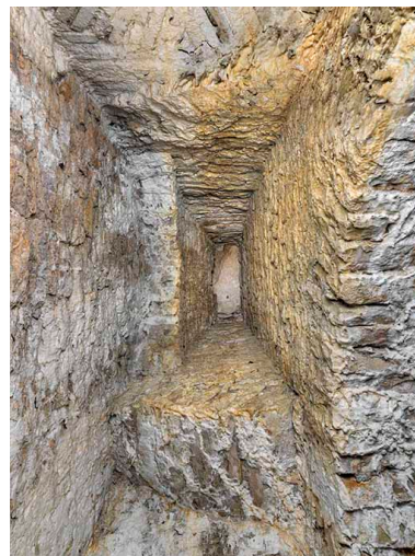
Hotte d'une cheminée.
