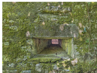
Vue extérieure d'une embrasure de tir de la galerie d'escarpe.
