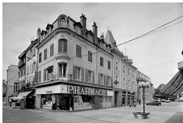
Vue d'ensemble. Phot. Jérôme Mongreville IVR43_19872500262V
