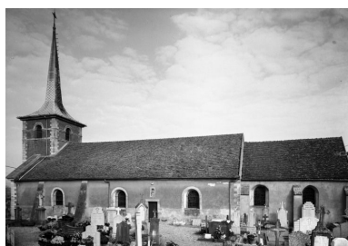
Elévation droite Phot. Jean-Luc Duthu IVR26_19852101674V
