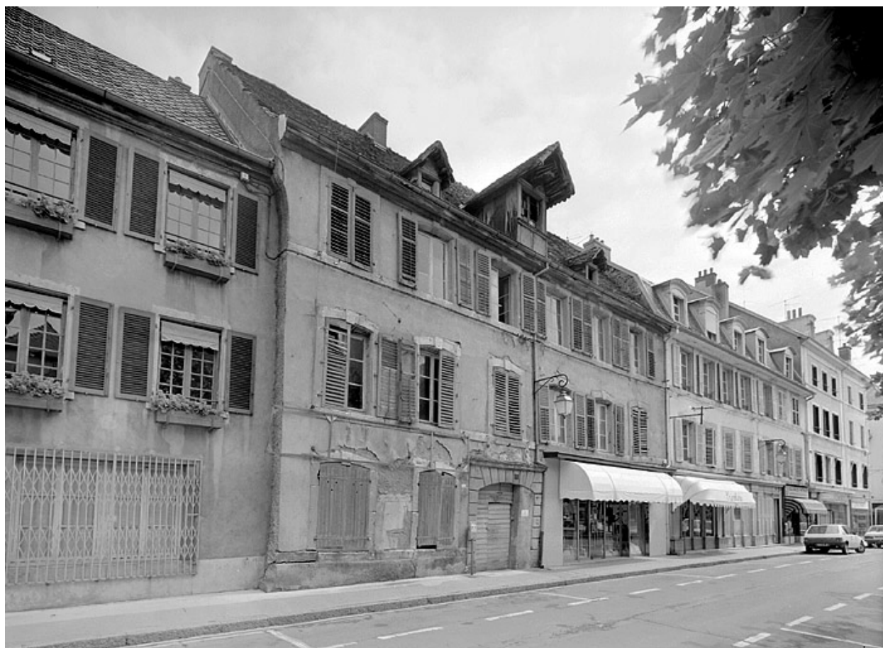
Façade principale sur la place Dorian.
