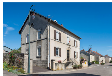
Mur pignon sud de l'édifice. Phot. Jérôme Mongreville IVR43_20177001085NUC4A
