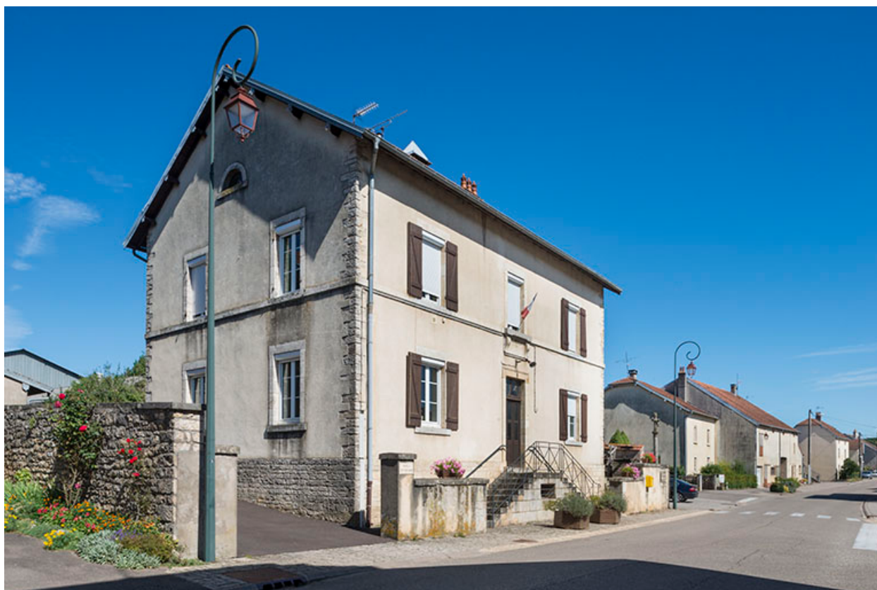
Mur pignon sud de l'édifice.
