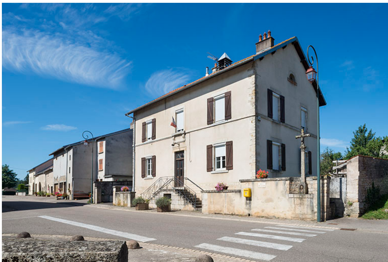
Vue d'ensemble de la maison commune.
