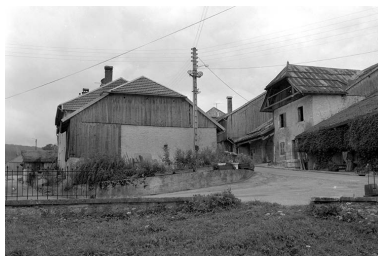
Fermes situées rue Saint-Jean. Phot. Yves Sancey IVR43_19782500505X
