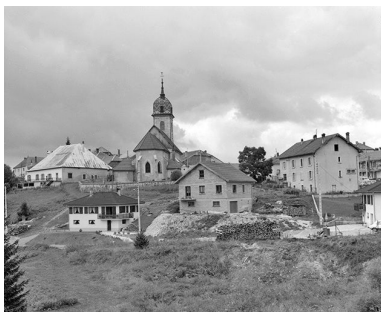
Fermes et église vues depuis l'est. Phot. Yves Sancey IVR43_19782500492X
