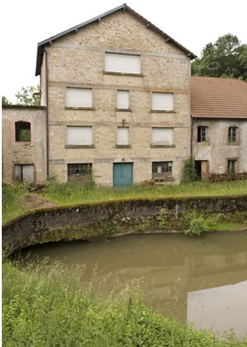
Façade de l'atelier de fabrication.
