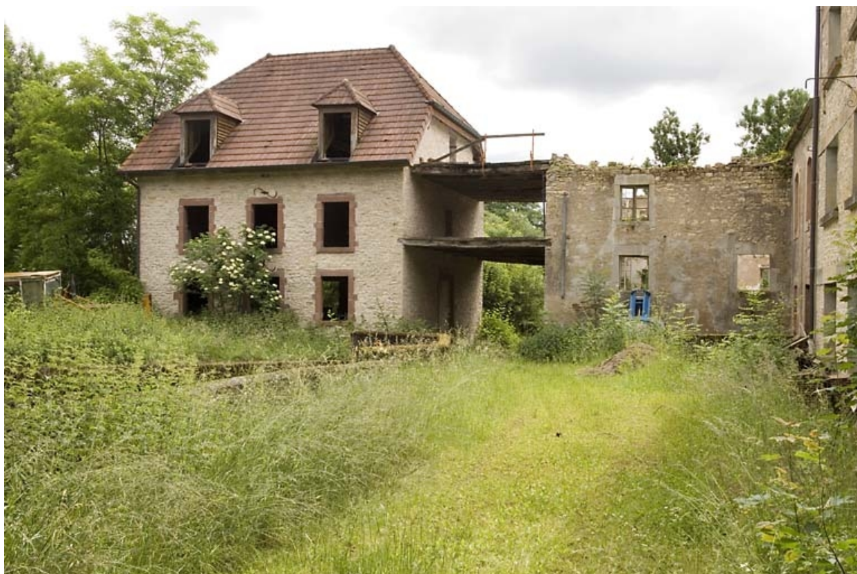
Logement et bâtiment en ruine.
