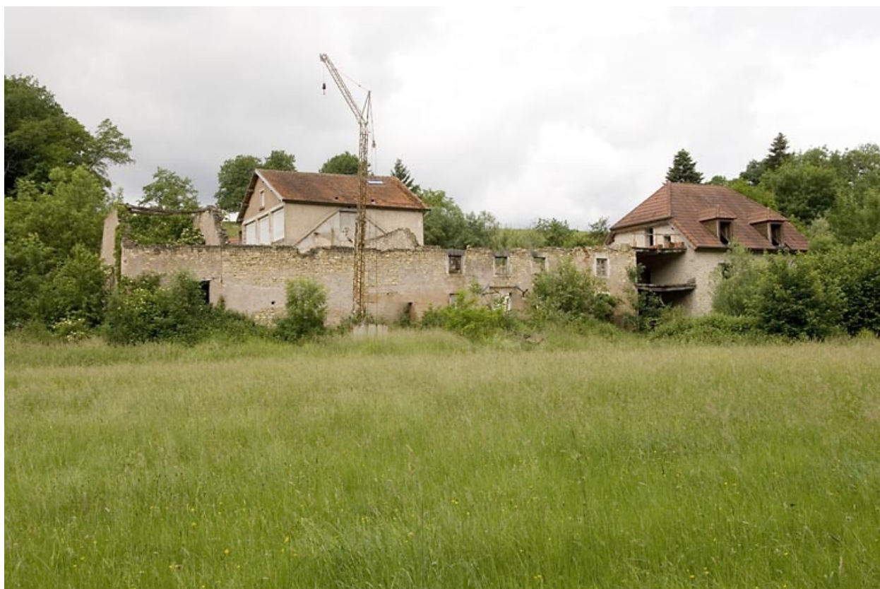
Bâtiment en ruine depuis l'est.
