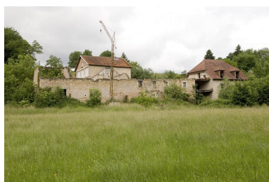
Bâtiment en ruine depuis l'est.
