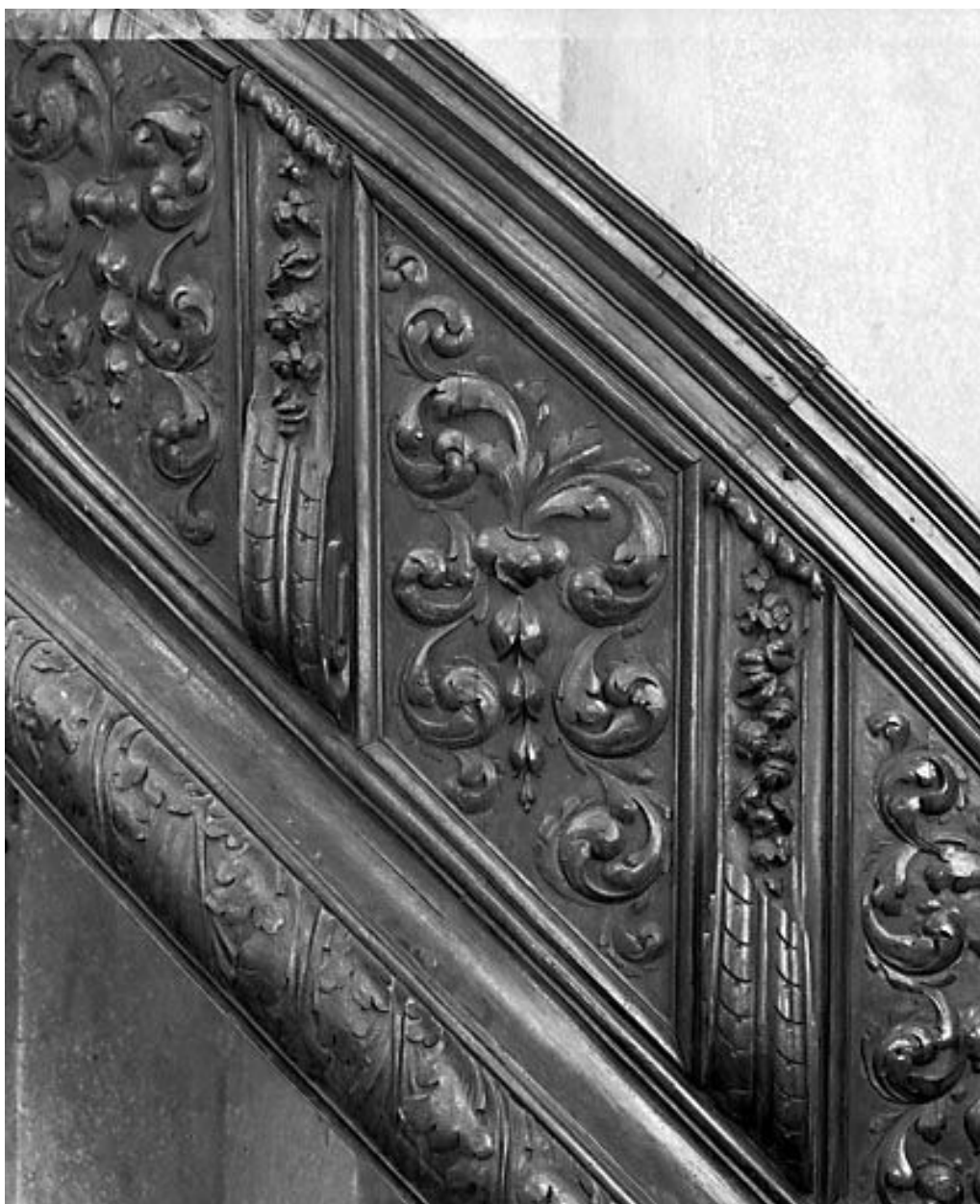
Détail de la rampe.
