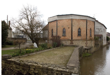
Vue depuis l'est. Phot. Jérôme Mongreville IVR43_20067000119NUCA
