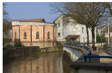
Vue d'ensemble en aval de la Lizaine. Phot. Jérôme Mongreville IVR43_20067000116NUCA
