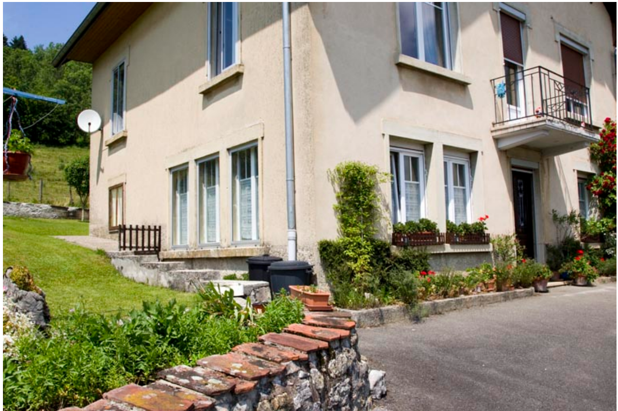
Fenêtres de l'atelier.
