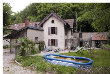
Vue d'ensemble des communs. Phot. Jérôme Mongreville IVR43_20112501578NUC4A
