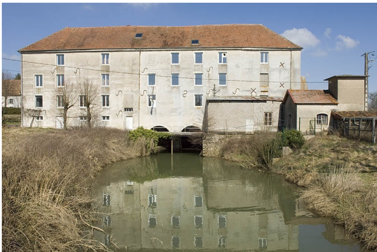
La minoterie et le canal de fuite.
