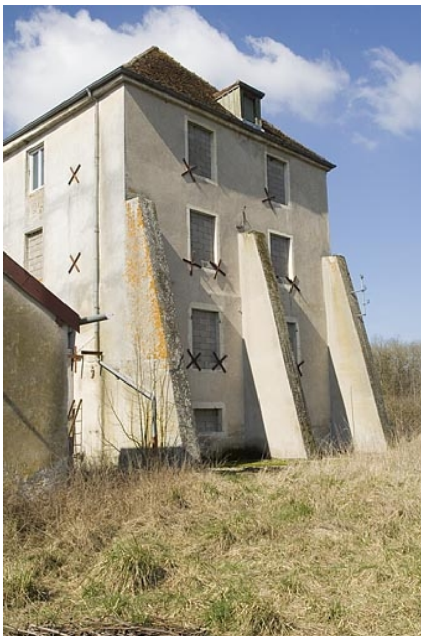
Contreforts sur le mur-pignon est.
