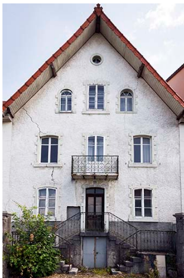
Bâtiment des années 1914-1918 : façade antérieure.
