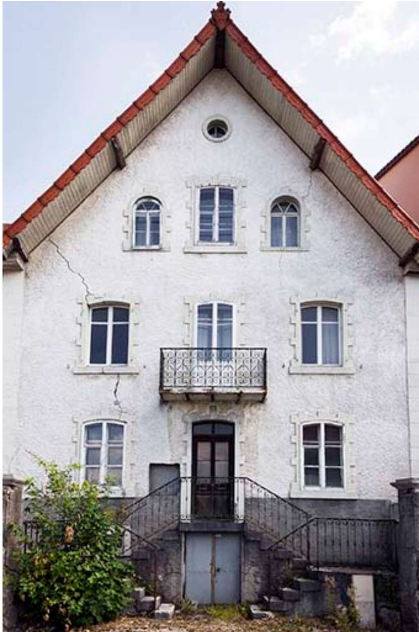
Bâtiment des années 1914-1918 : façade antérieure.
