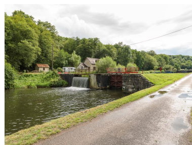
Vue du déversoir de superficie. Phot. Pierre-Marie Barbe-Richaud IVR26_20175800254NUC2A
