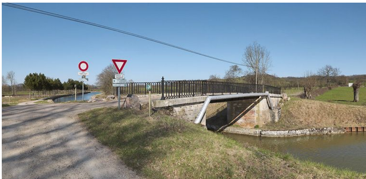
Le pont vu d'amont.
