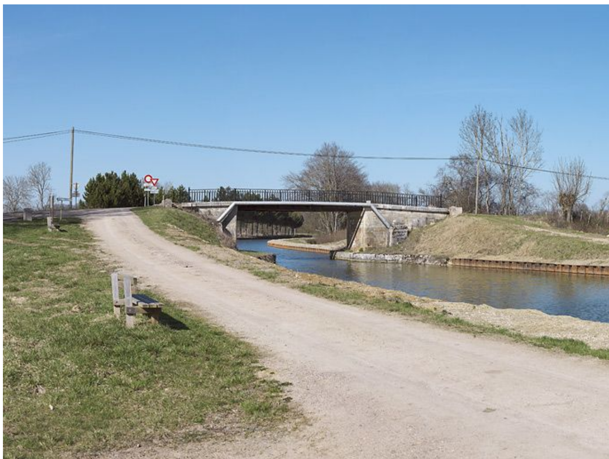
Le pont vu d'amont.
