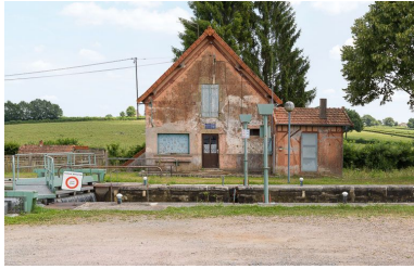
La maison éclusière de face.
