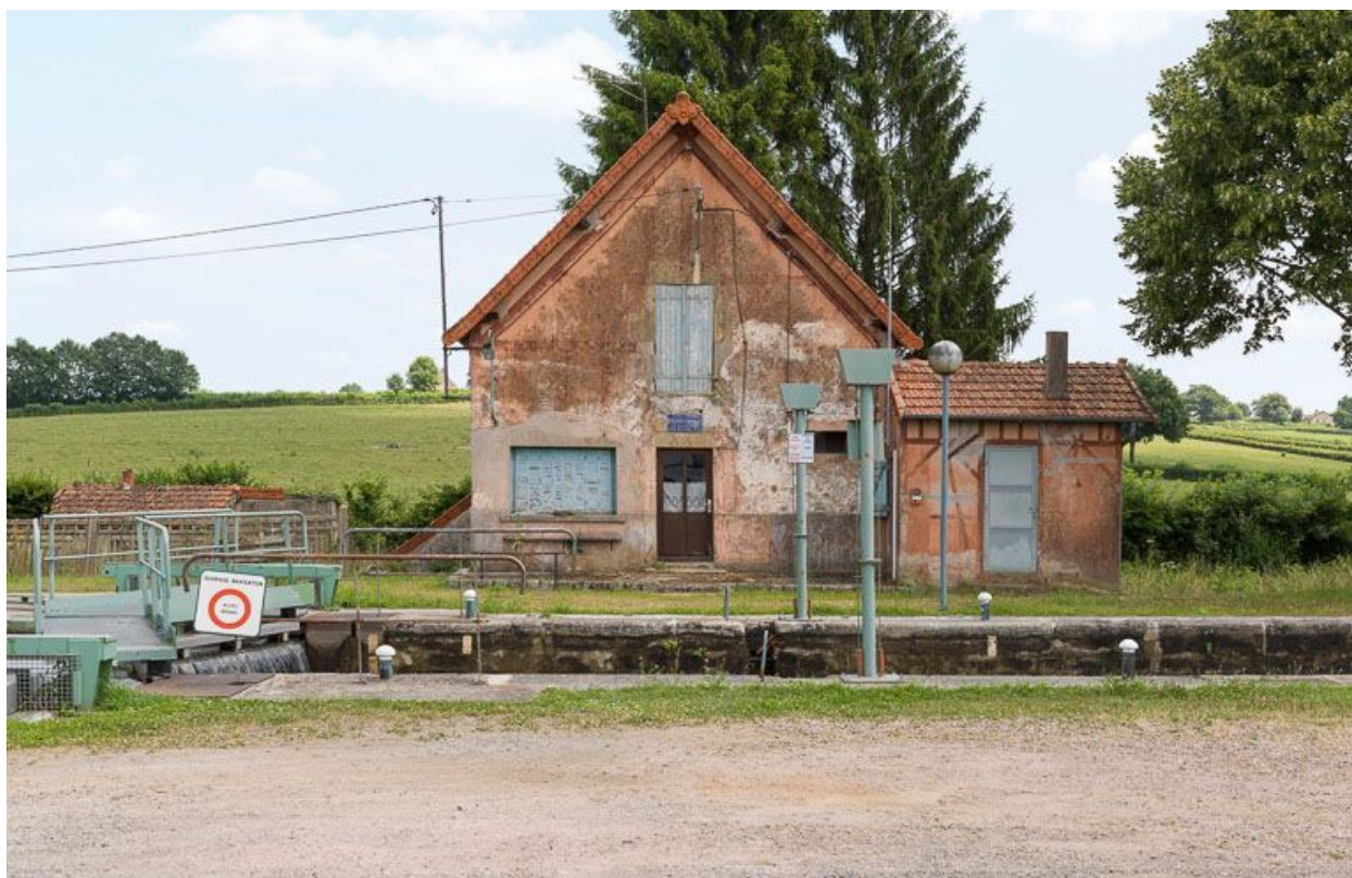
La maison éclusière de face.
