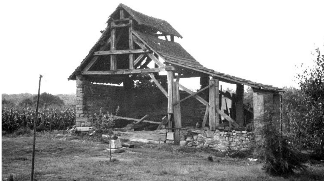
Hangar (abri du four), depuis l'est.
