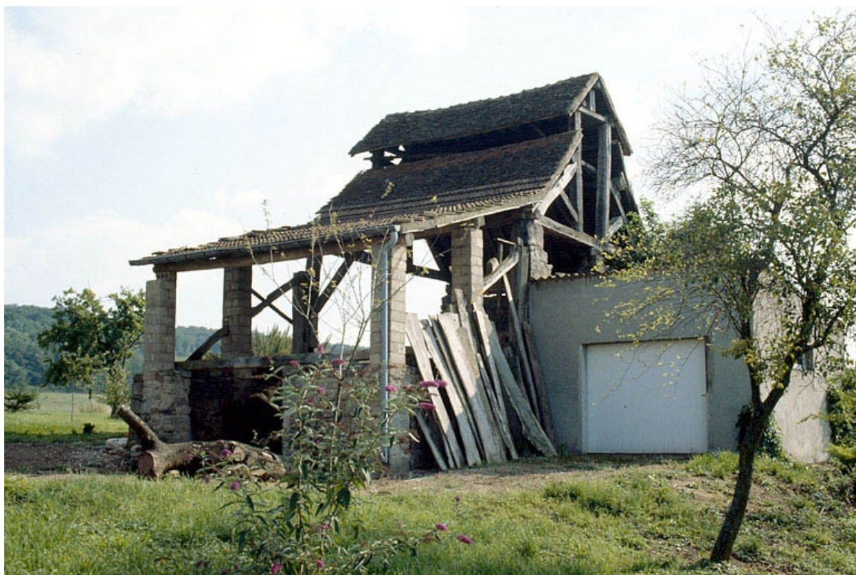
Hangar (abri du four), depuis le nord.
