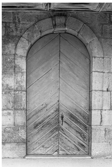
Portail latéral donnant dans le vestibule. Phot. Gilbert Poinot IVR43_19742500698Z
