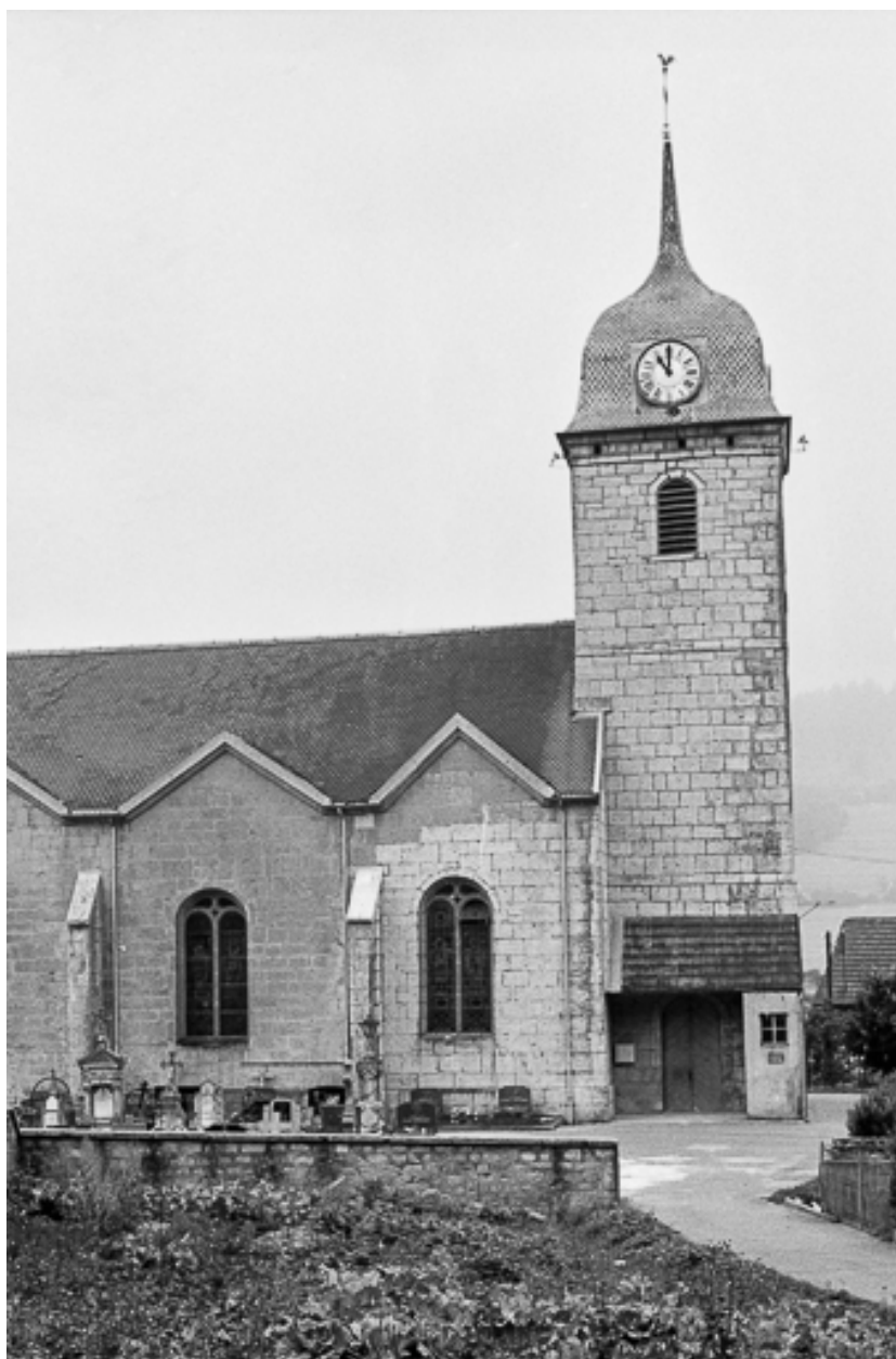
Façade latérale gauche et clocher.
