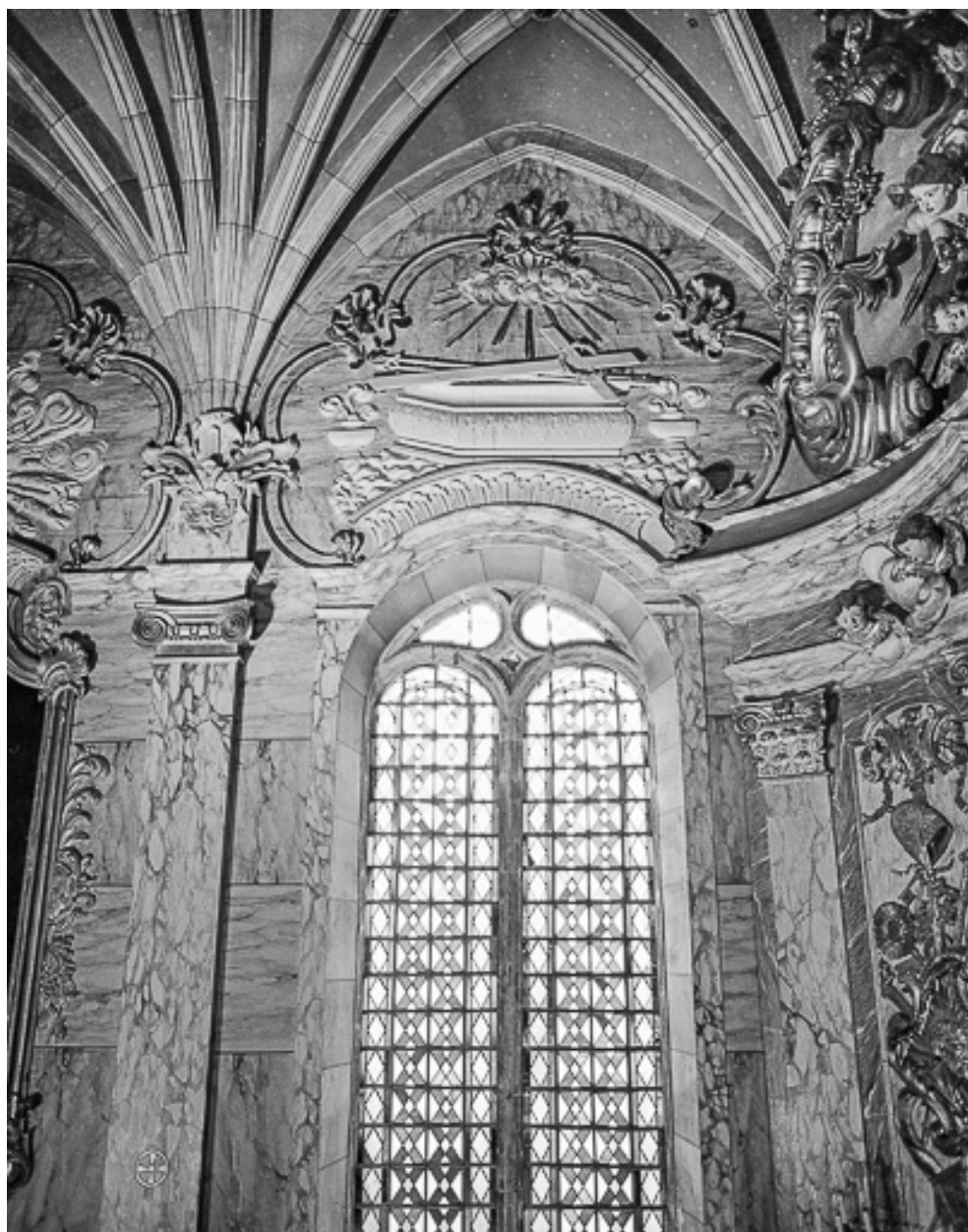
Mur gauche, deuxième travée.
