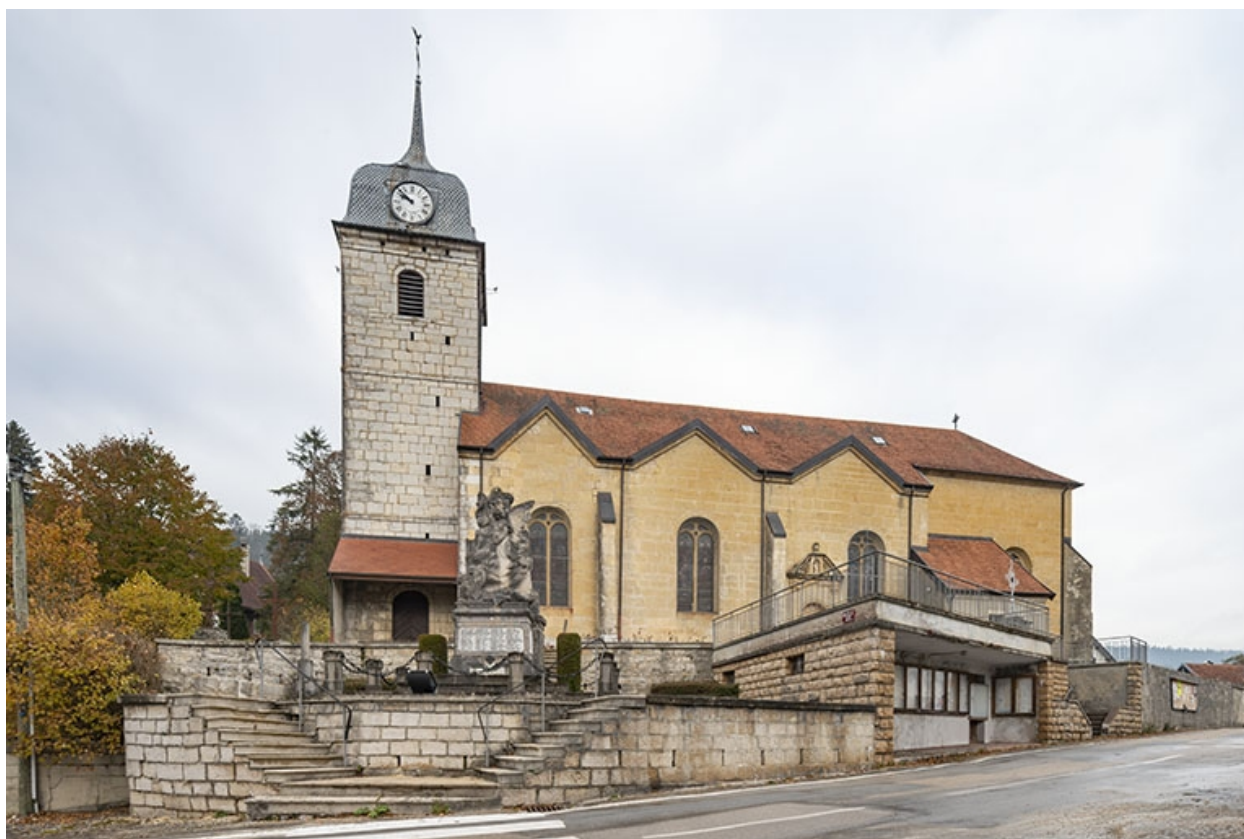
Façade latérale droite en 2021.
