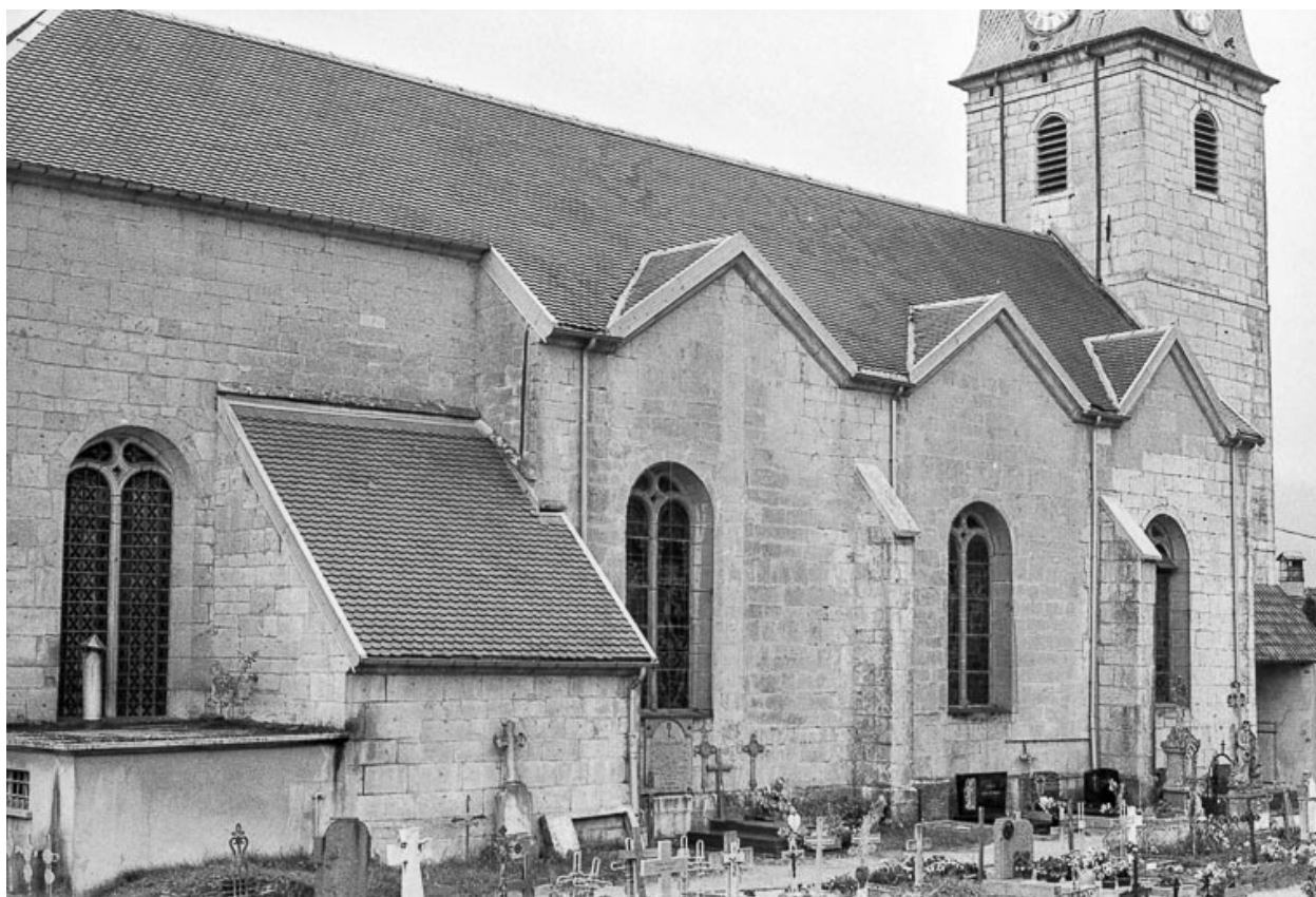
Façade latérale gauche, vue du nord-est.
