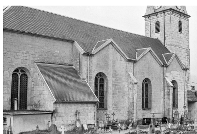
Façade latérale gauche, vue du nord-est. Phot. Gilbert Poinot IVR43_19742500697Z
