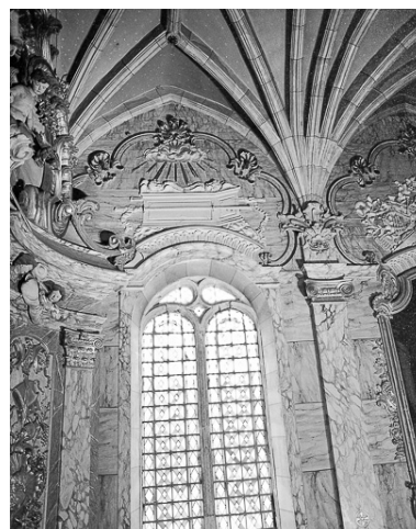
Mur droit, deuxième travée.
