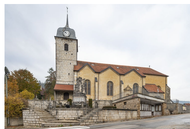
Façade latérale droite en 2021. Phot. Jérôme Mongreville IVR43_20212500314NUC4A
