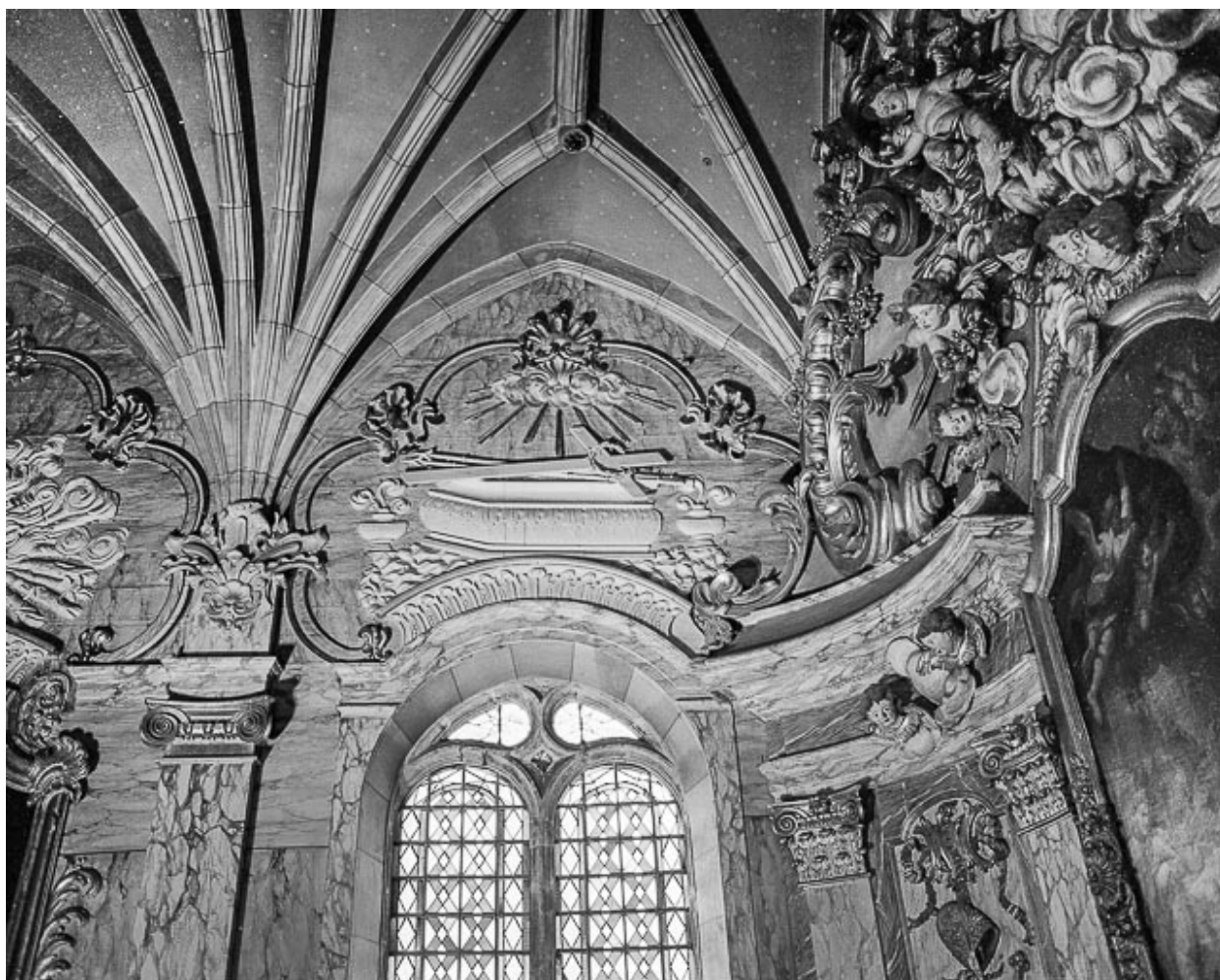
Mur gauche, deuxième travée.
