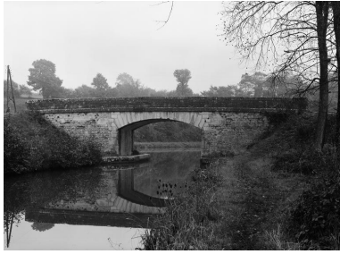
Vue d'ensemble. Phot. non renseigné IVR26_19755800627V
