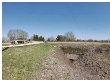
Un ponton sur le contre-fossé du canal au site d'écluse 16 du versant Yonne, rive gauche, à Charigny.
