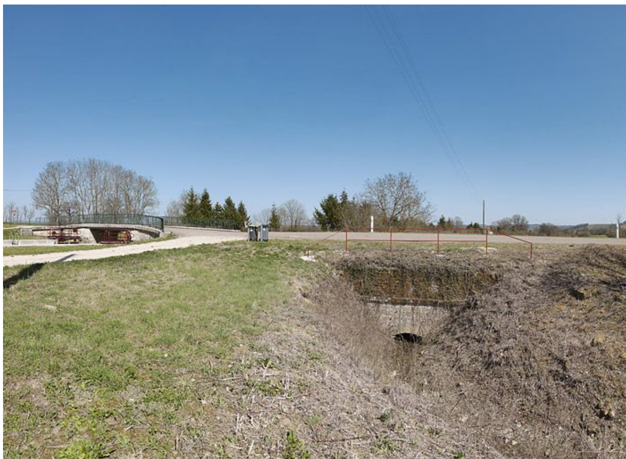
Un ponceau sur le contre-fossé du canal au site d'écluse 16 du versant Yonne, rive gauche, à Charigny.
