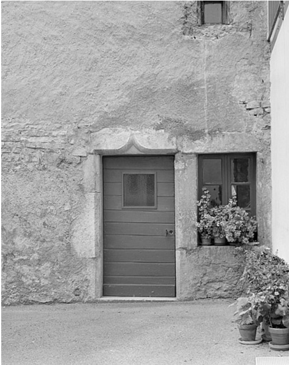
Porte d'accès avec linteau en accolade.
