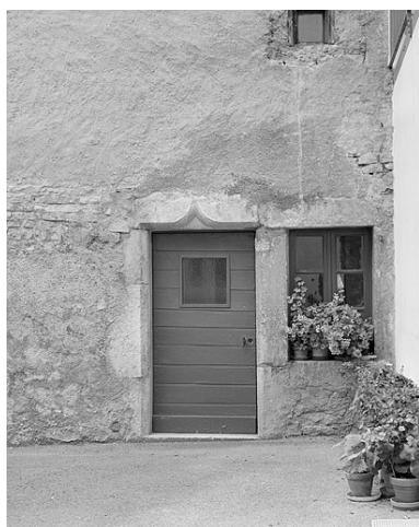
Porte d'accès avec linteau en accolade. Phot. Jérôme Mongreville IVR43_19963901028X
