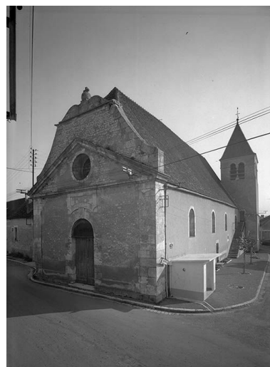
Façade et élévation droite. IVR26_19728900138V
